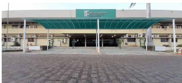
Foto 30: Estacionamento específico na recepção do Campus Petrolina e piso podotátil
