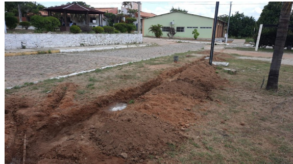
Foto 22: Serviços preliminares para execução de calçadas com piso podotátil – ao lado do Bloco F e em frente à Biblioteca
