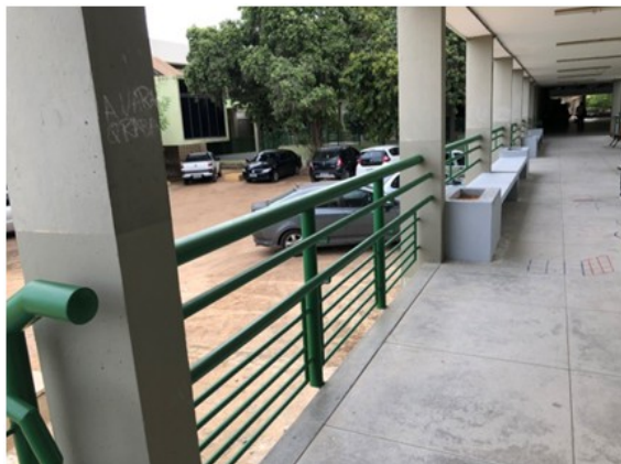
Foto 3: Guarda-corpo – áreas de circulação
