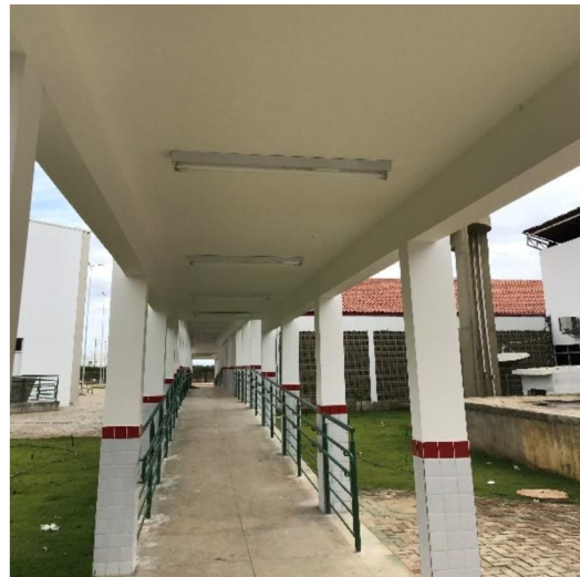
Foto 8: Corrimãos e guarda-corpo – Ampliação
