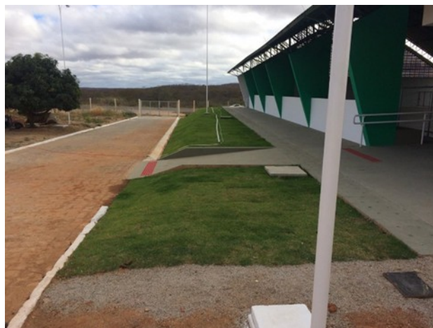
Foto 7: Rebaixo na calçada para acesso à quadra, com piso podotátil de alerta
