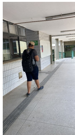
Foto 23: Piso podotátil no Pátio em direção a Biblioteca
