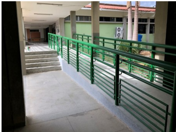
Foto 7: Rampa com guarda-corpo – Pátio/Bloco Administrativo
