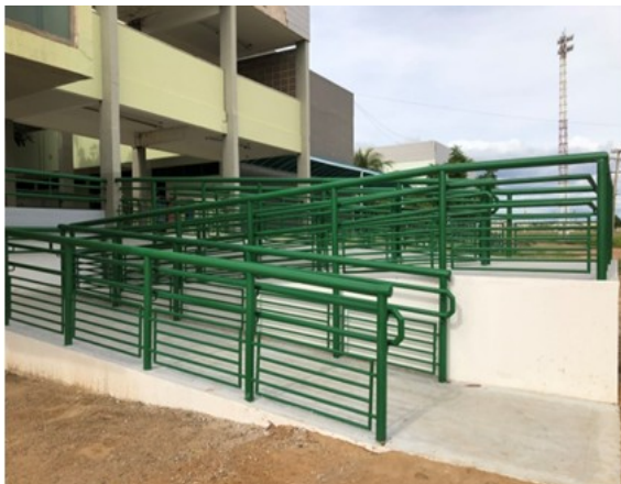
Foto 1: Rampa com corrimão e guarda-corpo na área do estacionamento interno
