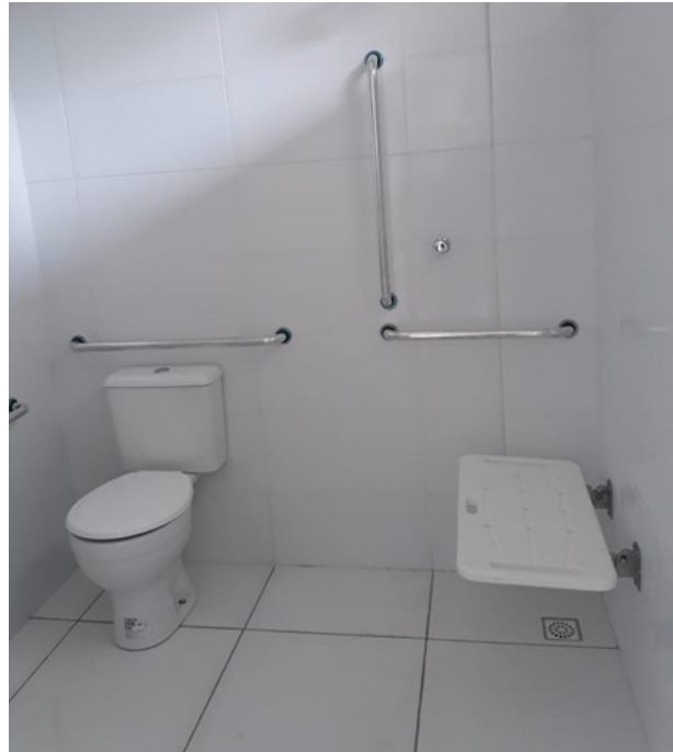
Foto 6: Banheiro com barras de apoio e banco articulado – Reforma do prédio existente
