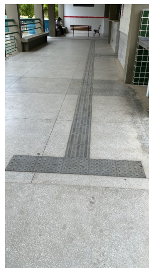
Foto 21: Piso podotátil na área de acesso ao Pátio
