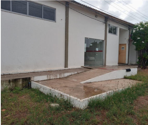
Foto 14: Rampa de acesso com sinalização de piso podotátil – Padaria
