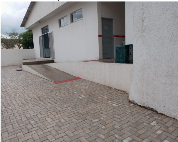
Foto 16: Rampa com sinalização de piso podotátil – Entrada de funcionários Refeitório
