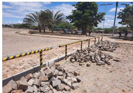
Foto 26: Serviços preliminares para execução de calçadas com piso podotátil – Entrada do campus
