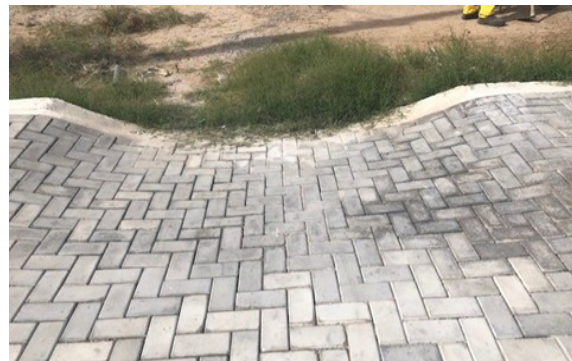
Foto 4: Rebaixo na calçada para facilitar trânsito
