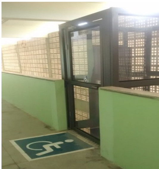
Foto 11: Plataforma elevatória – Bloco Administrativo
