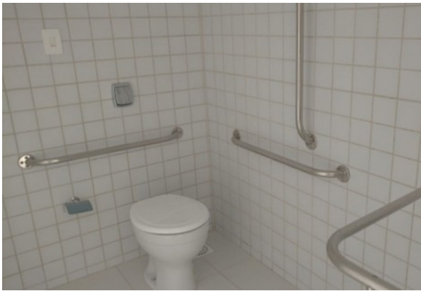
Foto 8: Banheiro acessível com barras de apoio
