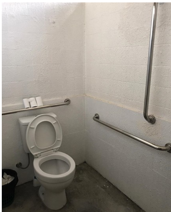
Foto 1: Sanitários acessíveis com barras de apoio em cada pavimento
