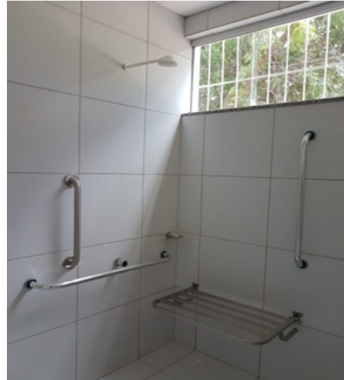
Foto 2: Banheiros acessíveis com barras de apoio
