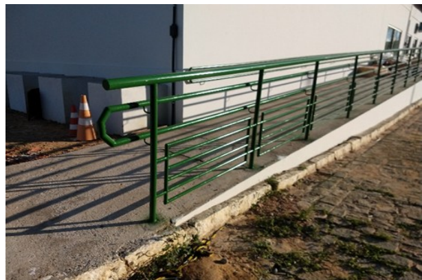
Foto 11: Rampa com corrimãos e guarda-corpo
