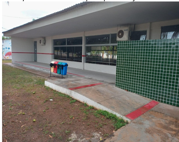
Foto 17: Rampa com sinalização de piso podotátil – Entrada secundária do Refeitório
