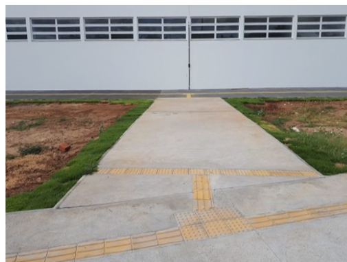
Foto 2: Calçada com piso podotátil
