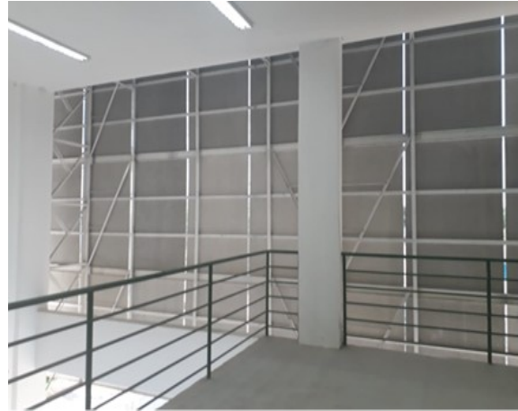
Foto 16: Guarda-corpos no pavimento superior do auditório
