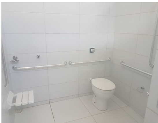
Foto 1: Barras de apoio e banco articulado
