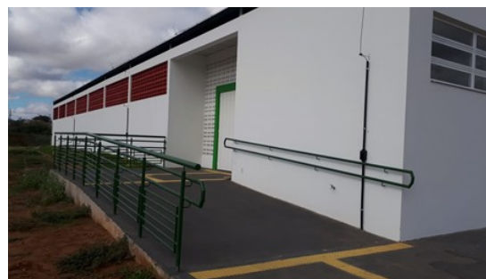
Foto 4: Rampa com corrimãos e guarda-corpo
