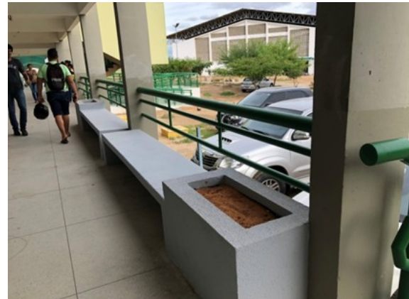
Foto 4: Guarda-corpo – áreas de circulação
