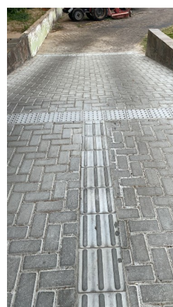
Foto 27: Rampa de acesso a recepção do Campus Petrolina e piso podotátil
