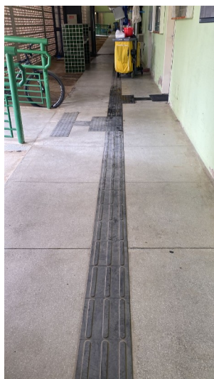
Foto 20: Piso podotátil no Bloco Administrativo
