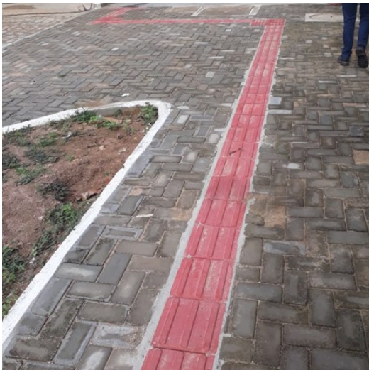
Foto 7: Piso tátil – Prédio existente
