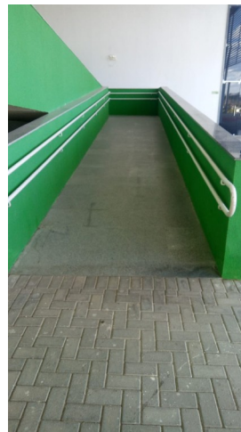
Foto 8: Rampa com corrimão.
