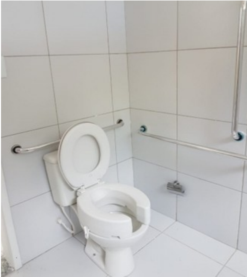
Foto 1: Banheiros acessíveis com barras de apoio
