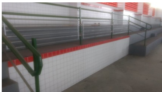
Foto 3: Corrimãos e guarda-corpo
