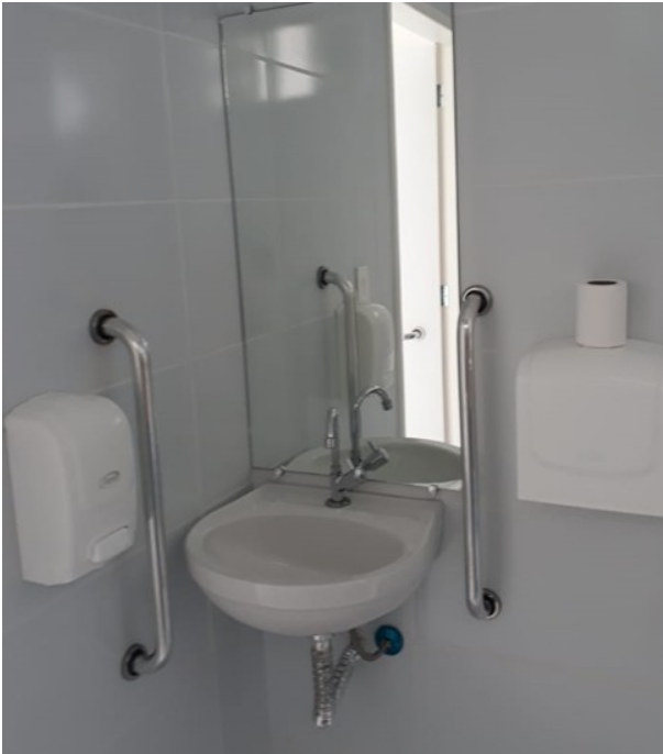
Foto 5: Banheiro acessível com barras de apoio – Reforma do prédio existente
