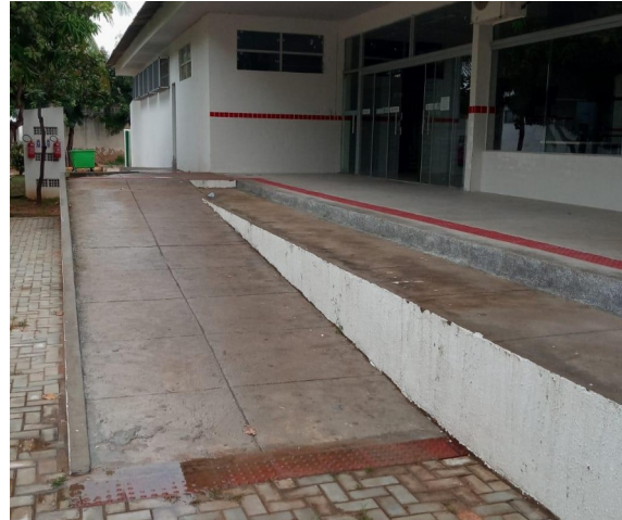
Foto 15: Rampa de acesso com sinalização de piso podotátil – Entrada principal do Refeitório
