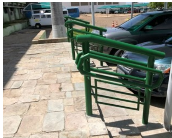
Foto 10: Escada da entrada do campus com corrimãos e guarda-corpo
