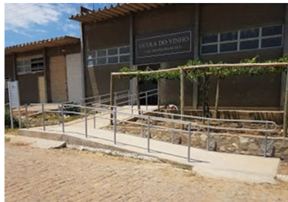
Foto 13: Rampa para acesso à Escola do Vinho
