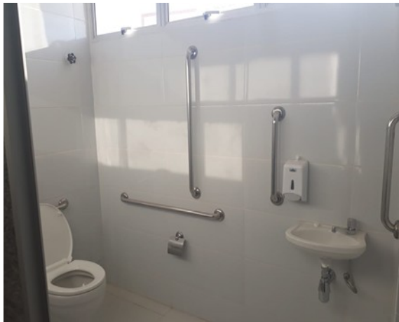
Foto 15: Um dos sanitários acessíveis
