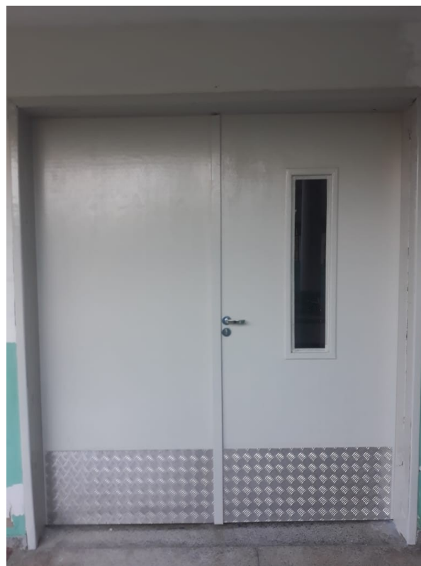
Foto 6: Porta instalada no Campus Floresta, com visor e chapa de proteção.
