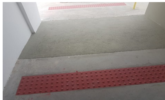
Foto 4: Rampa e piso podotátil de alerta
