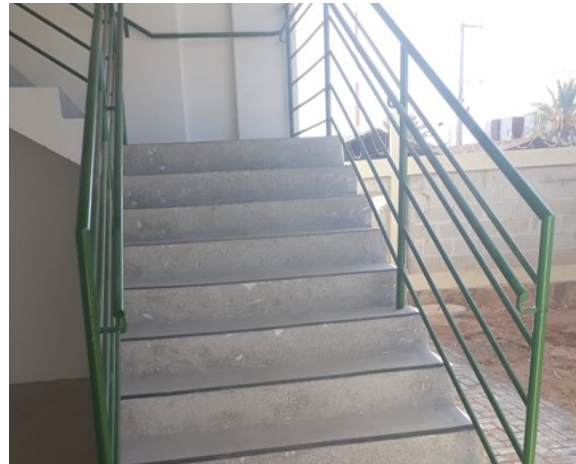
Foto 18: Escada com corrimãos, faixa de sinalização e guarda-corpo – acesso ao pavimento superior do auditório
