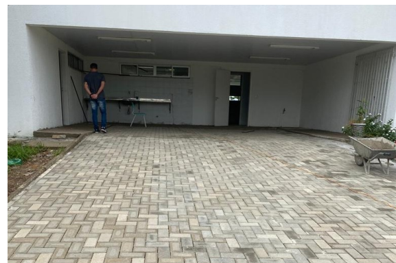
Foto 4: Piso intertravado consertado – depois
