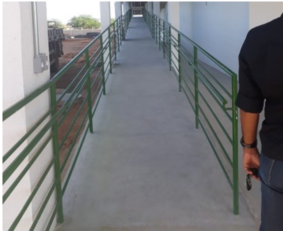
Foto 17: Rampa com corrimãos e guarda-corpo – acesso ao pavimento superior do auditório
