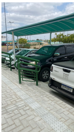
Foto 28: Estacionamento específico na recepção do Campus Petrolina e piso podotátil
