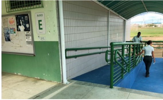
Foto 5: Rampa com corrimão e guarda-corpo – Bloco E de Química e Laboratórios de Alimentos
