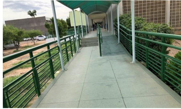
Foto 6: Rampa com corrimão e guarda-corpo – Bloco E de Química e Laboratórios de Alimentos
