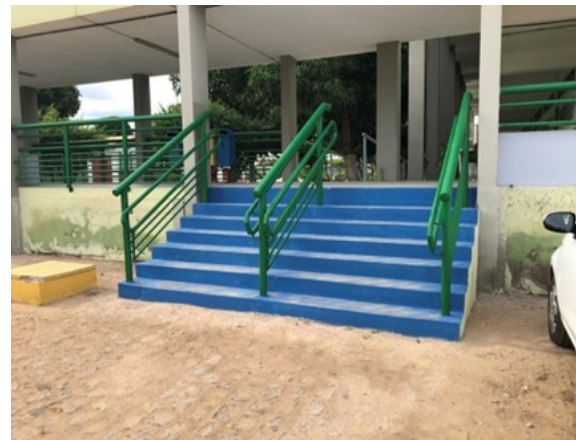
Foto 2: Escada externa com corrimão e guarda-corpo no estacionamento interno
