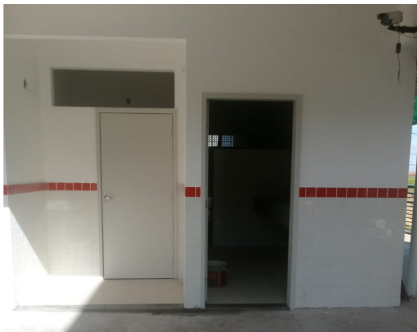
Foto 19: Remoção das portas antigas para substituir por portas que atendam à acessibilidade e individualização do acesso aos boxes acessíveis no Bloco D
