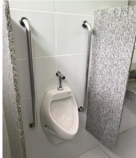
Foto 10: Banheiro acessível com barras de apoio no mictório – Ampliação
