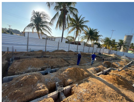
Figura 12. Escavação de valas de sapatas e vigas baldrame
