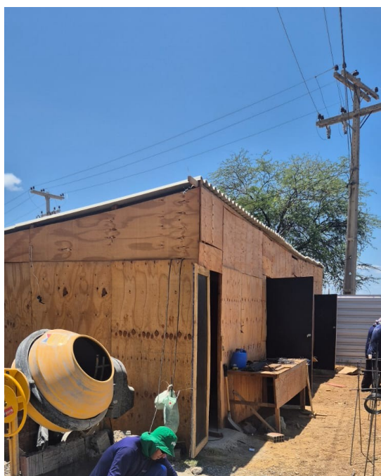
Figura 5. Construção do canteiro de obras
