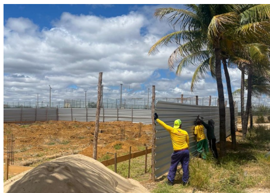
Figura 4. Instalação de tapume metálico
