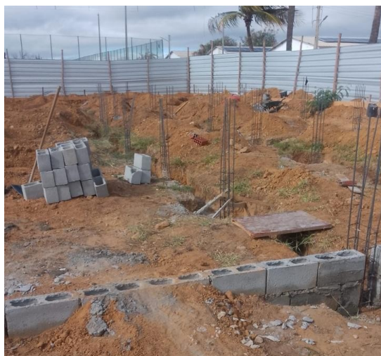
Figura 13. Execução de alvenaria de embasamento.
