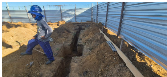
Figura 11. Escavação de valas de sapatas e vigas baldrame
