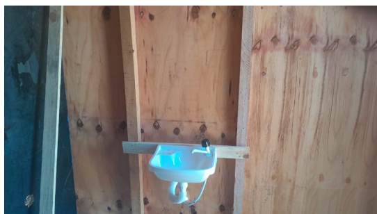
Figura 7. Construção do canteiro de obras
