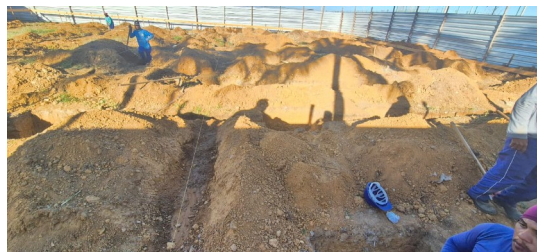
Figura 12. Escavação de valas de sapatas e vigas baldrame
