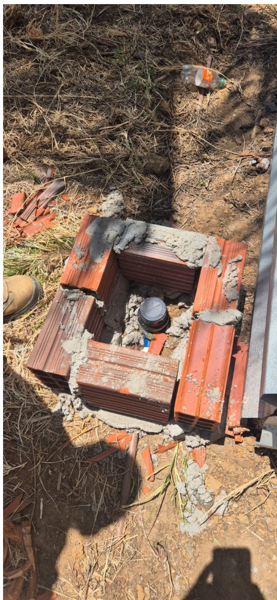
Figura 9. Ligação provisória de água
