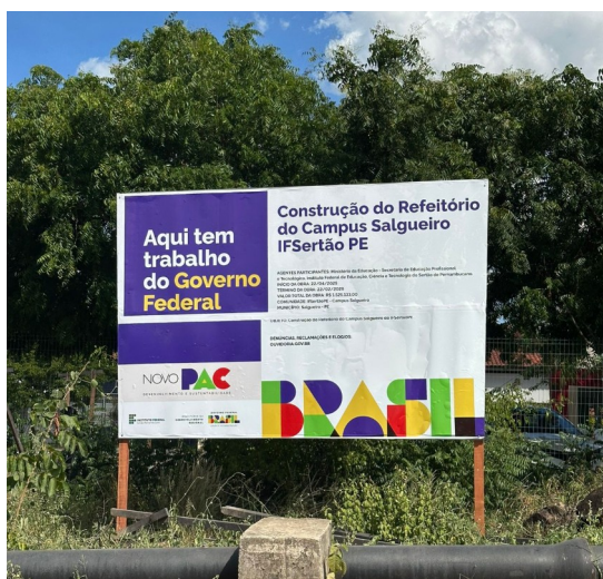
Figura 1. Placa de obra em chapa galvanizada e estrutura de madeira.
