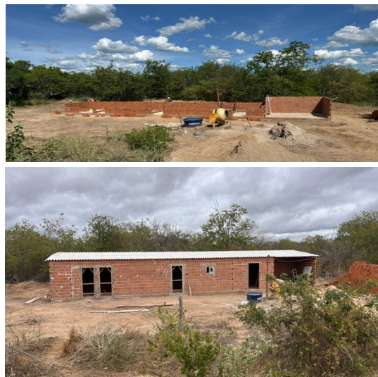
Figura 2. Construção do canteiro de obras
