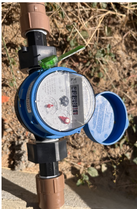
Figura 3. Ligação provisória de água
