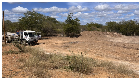
Figura 5. Limpeza do terreno
