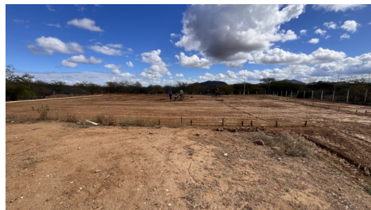
Figura 6. Execução e execução de base na área de implantação
