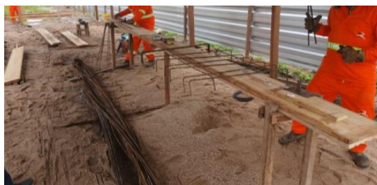
Figura 6. Armação de fundações.
