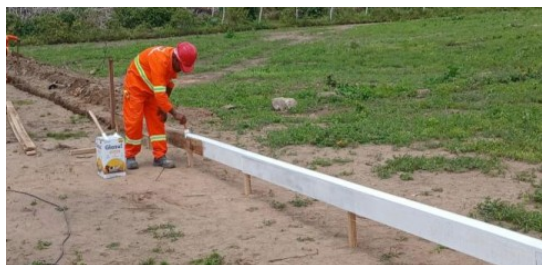
Figura 7. Locação de obra.
