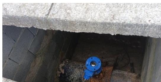
Figura 2. Ligação provisória de água.
