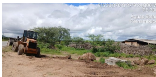
Figura 3. Limpeza mecanizada do terreno.
