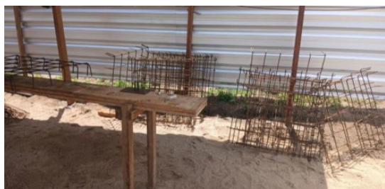
Figura 5. Armação de fundações.
