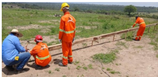
Figura 8. Locação de obra.
