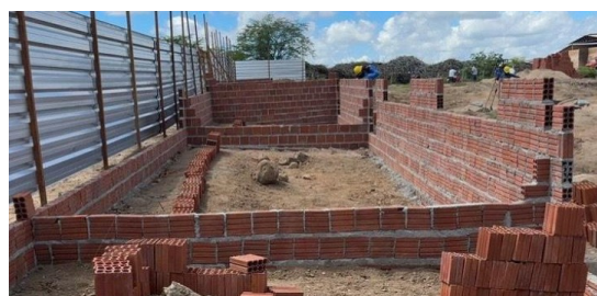
Figura 4. Construção do canteiro de obras.
