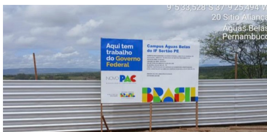
Figura 1. Instalação de placa de obra em chapa galvanizada.
