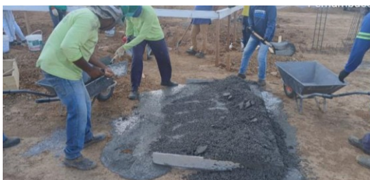
Figura 13. Concretagem de sapatas.
