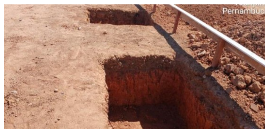
Figura 4. Escavação de sapatas.
