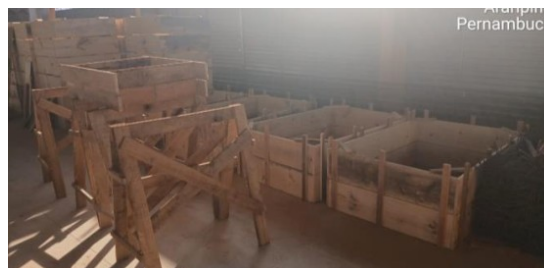
Figura 6. Montagem de forma de madeira para sapatas.
