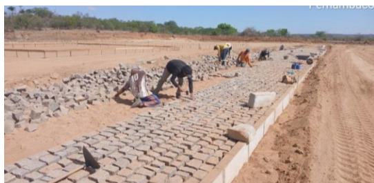
Figura 17. Execução de pavimento em paralelepípedos.
