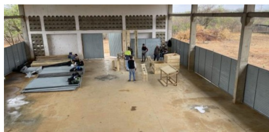
Figura 20. Canteiro de obras.
