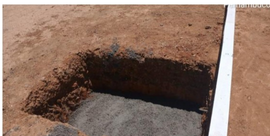
Figura 9. Execução de lastro de concreto em valas de sapatas.
