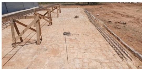
Figura 7. Montagem de armação para vigas baldrame.
