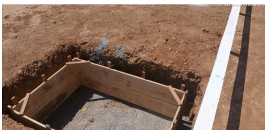
Figura 11. Colocação de forma de madeira para sapatas.
