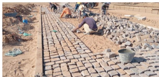
Figura 18. Execução de pavimento em paralelepípedos.
