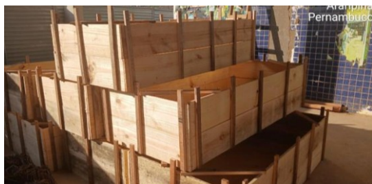
Figura 5. Montagem de forma de madeira para sapatas.
