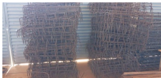
Figura 8. Montagem de armação para sapatas.
