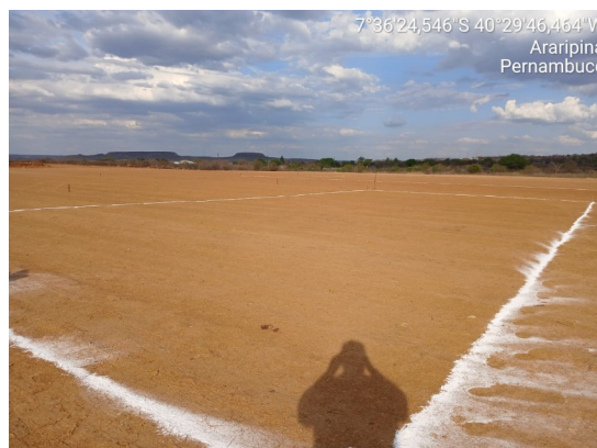
Figura 22. Limpeza mecanizada do terreno.
