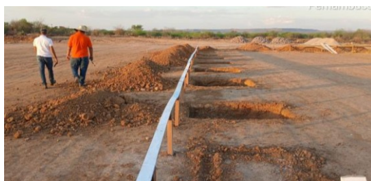
Figura 3. Escavação de sapatas.
