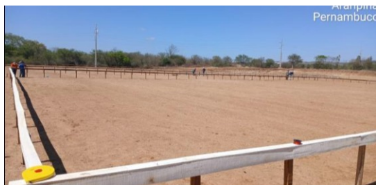
Figura 1. Locação de obra, utilizando gabarito de tábuas corridas.
