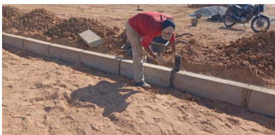
Figura 15. Assentamento de meio-fio de concreto pré-fabricado.
