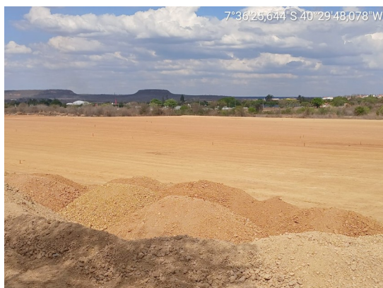
Figura 21. Limpeza mecanizada do terreno.
