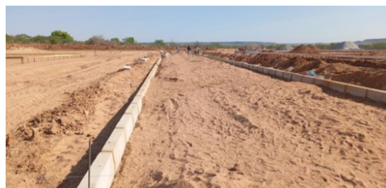
Figura 16. Assentamento de meio-fio de concreto pré-fabricado.
