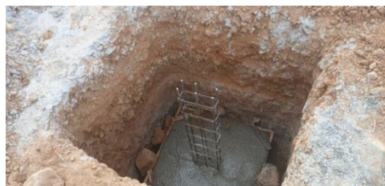
Figura 14. Concretagem de sapatas.
