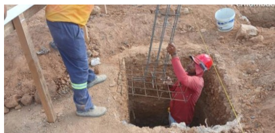
Figura 12. Colocação de armação para sapatas.
