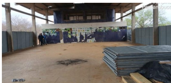
Figura 19. Canteiro de obras.
