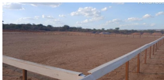
Figura 2. Locação de obra, utilizando gabarito de tábuas corridas.
