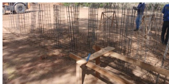
Figura 10. Montagem de armação de tocos de pilar.
