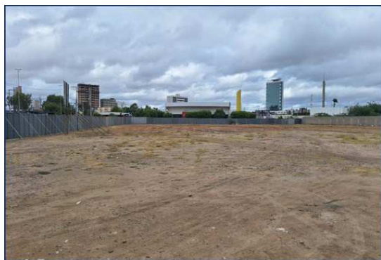
Figura 3. Limpeza do terreno
