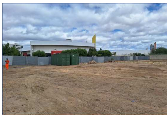
Figura 2. Containers para canteiro de obras
