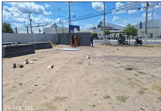
Figura 5. Colocação de tapume metálico
