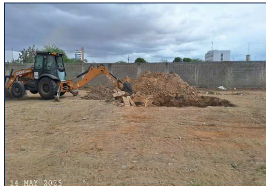
Figura 6. Escavação do poço do elevador
