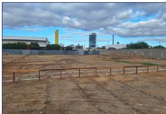
Figura 4. Locação de obra
