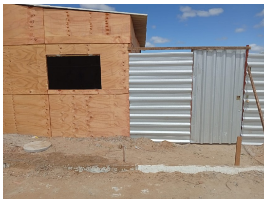
Figura 5. Construção do canteiro de obras
