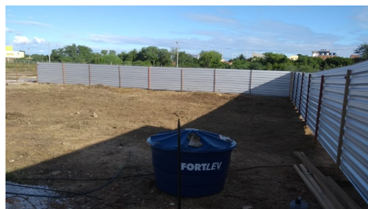
Figura 2. Limpeza do terreno
