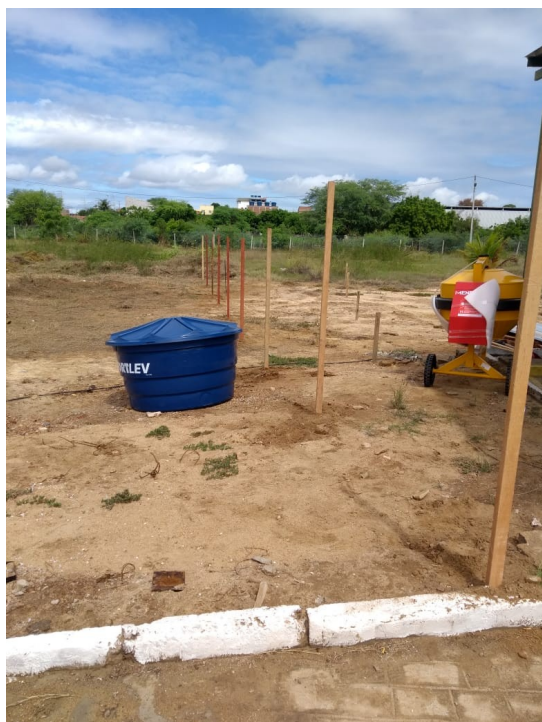
Figura 3. Locação de obra
