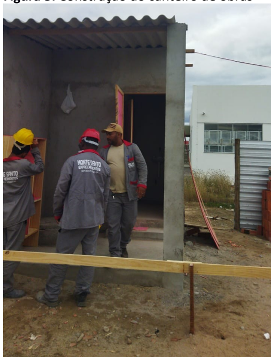
Figura 7. Construção do canteiro de obras
