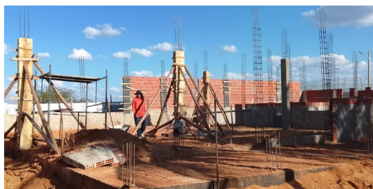
Figura 5. Montagem de forma de pilar.
