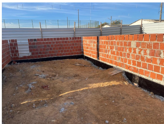
Figura 9. Assentamento de alvenaria de blocos cerâmicos.
