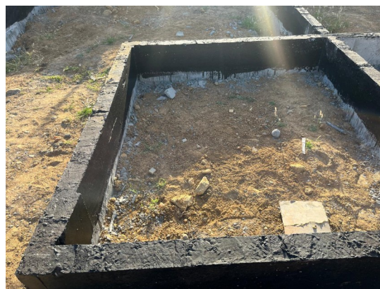
Figura 2. Impermeabilização de vigas baldrames.
