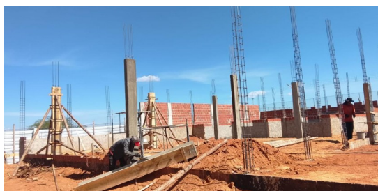
Figura 7. Concretagem de pilar.
