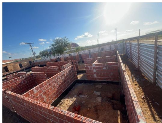
Figura 10. Assentamento de alvenaria de blocos cerâmicos.
