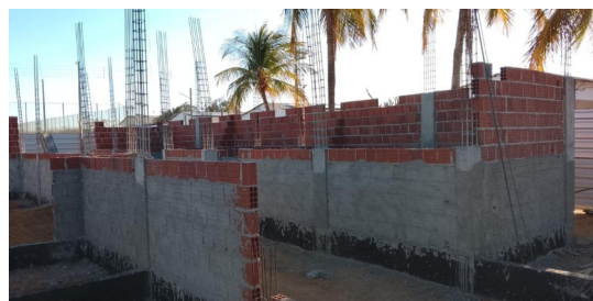
Figura 8. Armação e concretagem de pilar e assentamento de alvenaria de vedação com blocos cerâmicos.
