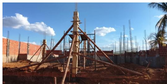
Figura 6. Montagem de forma de pilar.
