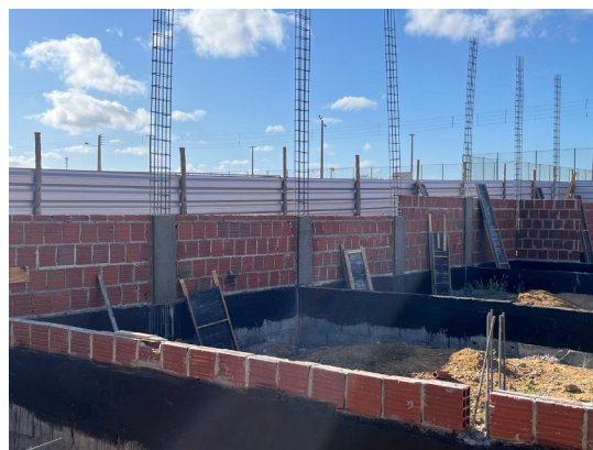
Figura 4. Armação de pilar e concretagem de toco de pilar.
