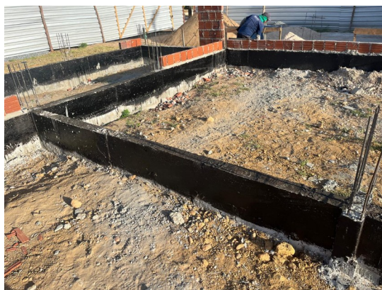
Figura 3. Impermeabilização de vigas baldrames.
