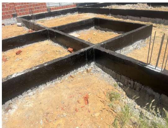
Figura 1. Impermeabilização de vigas baldrames.
