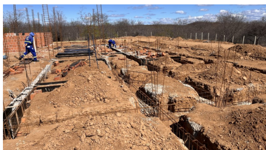
Figura 5. Armação e forma de baldrames e armação de pilares
