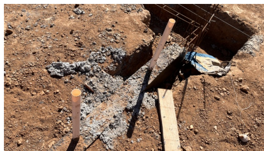
Figura 8. Concretagem de baldrame
