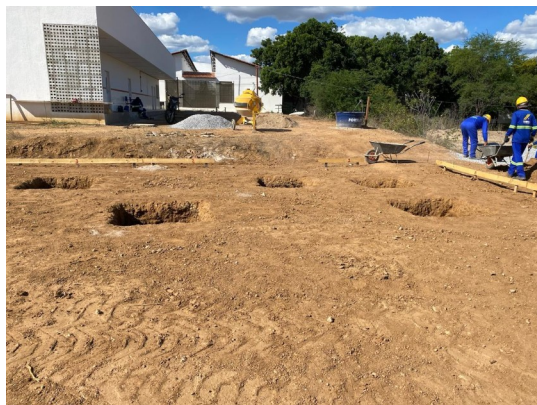
Figura 4. Valas de sapatas escavadas
