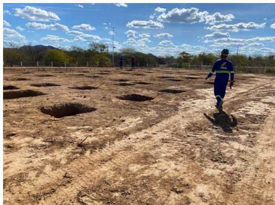
Figura 3. Valas de sapatas escavadas
