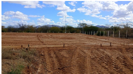
Figura 1. Área de implantação da obra compactada
