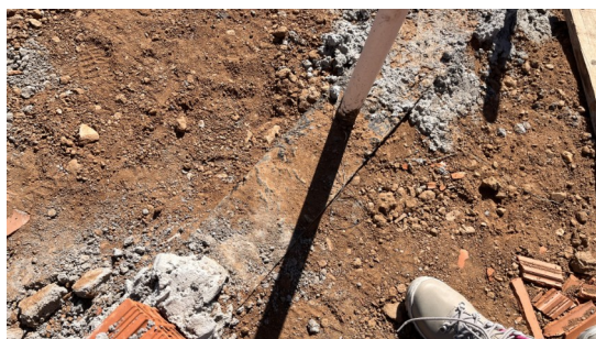
Figura 7. Concretagem de baldrame
