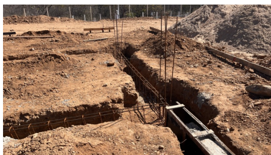
Figura 6. Armação e forma de baldrames e armação de pilares
