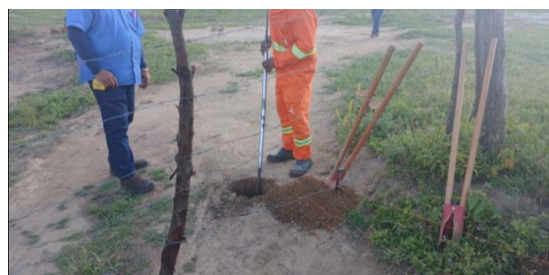
Figura 6. Locação de estacas.
