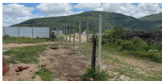
Figura 12. Assentamento de mourões de concreto para execução da cerca.
