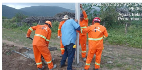
Figura 11. Assentamento de mourões de concreto para execução da cerca.
