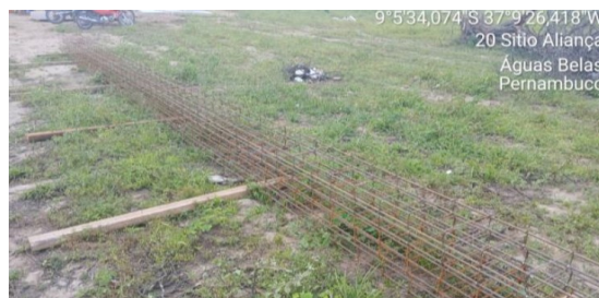
Figura 4. Montagem de armação para fundações.
