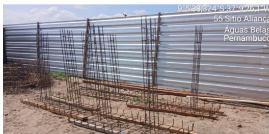
Figura 3. Fabricação de armação para fundações.
