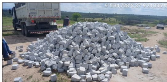
Figura 9. Material para execução de pavimentação das vias.
