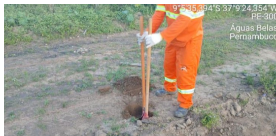
Figura 10. Escavação de valas para assentamento de mourões de concreto.
