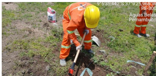
Figura 1. Escavação de valas para sapatas.
