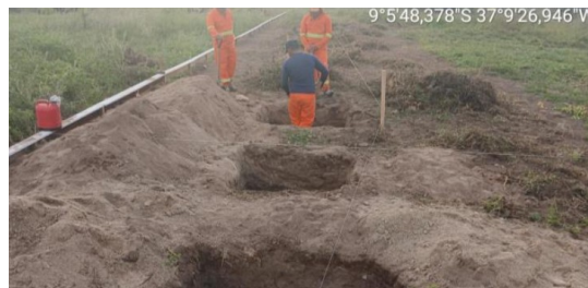
Figura 2. Escavação de valas para sapatas.
