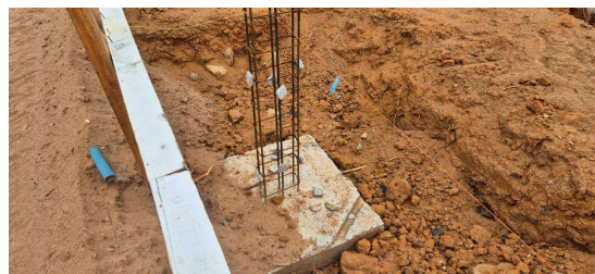
Figura 2. Reaterro e concreto de sapatas.
