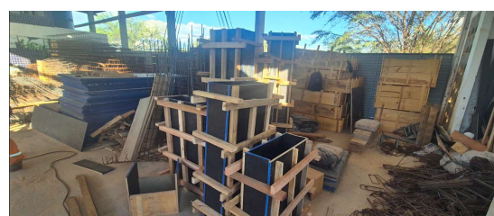
Figura 8. Montagem de forma de pilares.
