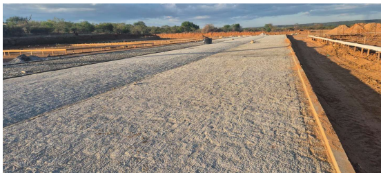
Figura 9. Execução de pavimentação em paralelepípedo e assentamento de meio-fio.
