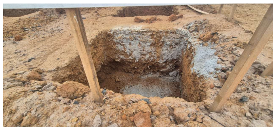
Figura 3. Escavação de sapatas.
