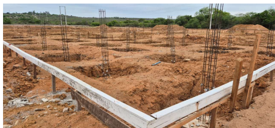
Figura 1. Concreto de sapatas.
