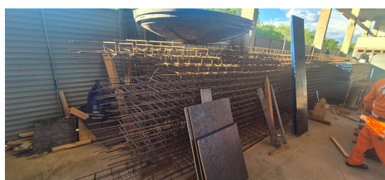
Figura 6. Armações de pilares e vigas.
