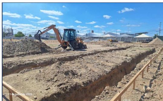
Figura 1. Escavação de valas para execução de fundações.
