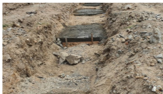
Figura 4. Execução de lastro de concreto magro em valas de sapatas isoladas.
