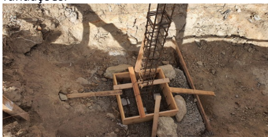
Figura 7. Montagem de forma de sapata e armação de arranque de pilar.
