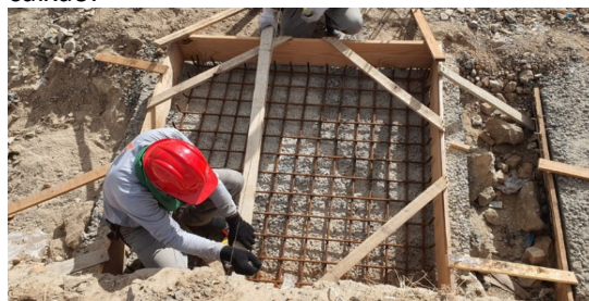
Figura 8. Montagem de forma de sapata e armação de sapata.
