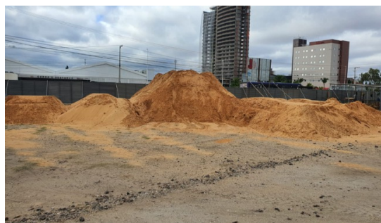
Figura 6. Material para execução de aterro de caixão.
