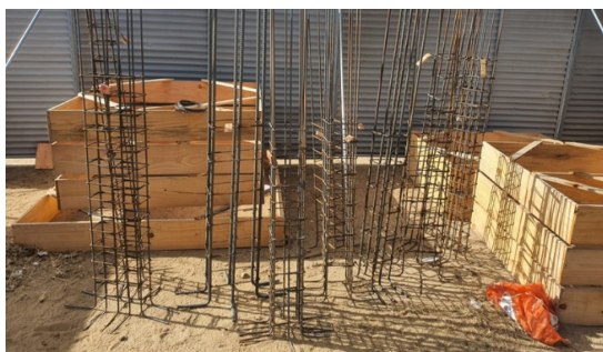
Figura 5. Fabricação de armação para fundações.
