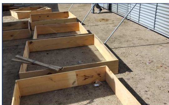
Figura 3. Fabricação de formas para fundações.
