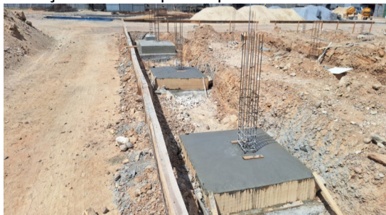
Figura 9. Concretagem de sapatas e armação de arranque de pilares.
