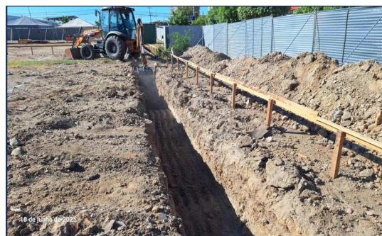
Figura 2. Escavação de valas para execução de fundações.
