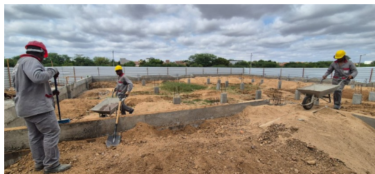
Figura 5. Concretagem de sapatas, arranque de pilares e vigas baldrames.
