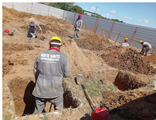
Figura 2. Escavação de valas de sapatas.
