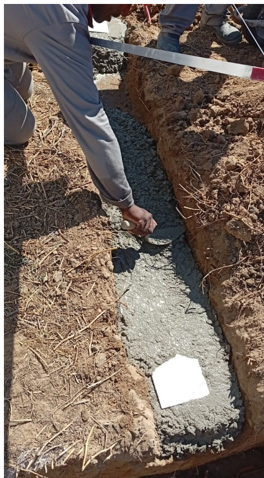
Figura 4. Execução de lastro de concreto magro em valas de vigas baldrame.
