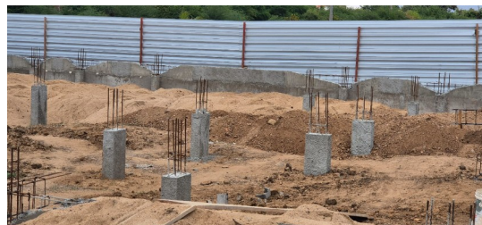
Figura 6. Concretagem de arranque de pilares.
