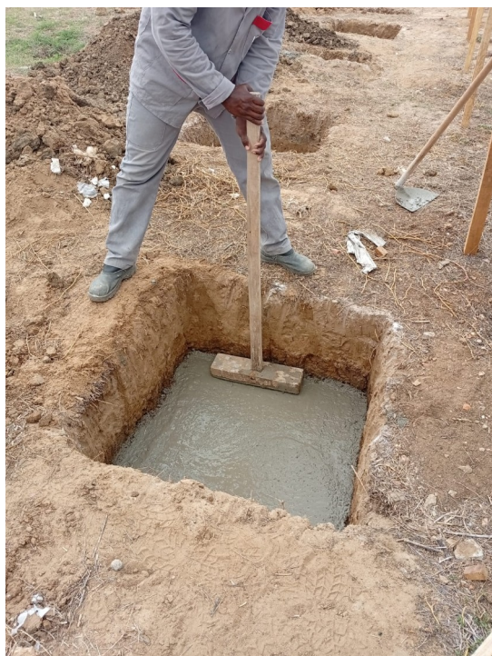
Figura 1. Escavação de valas de sapatas.
