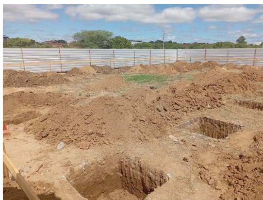
Figura 1. Escavação de valas de sapatas.
