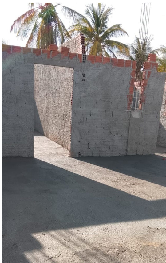
Figura 6. Aplicação de chapisco em alvenaria.
