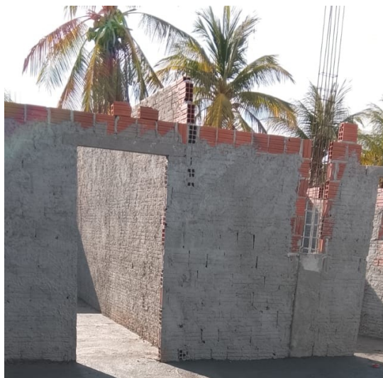
Figura 3. Aplicação de chapisco em alvenaria.
