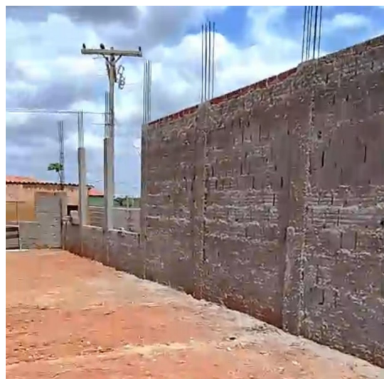
Figura 4. Aplicação de chapisco em alvenaria.
