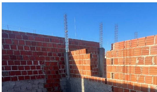
Figura 1. Montagem de armação de pilar.
