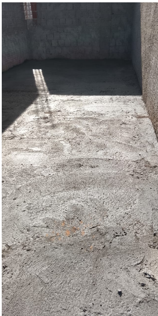
Figura 7. Aplicação de lastro de concreto magro em áreas de piso.
