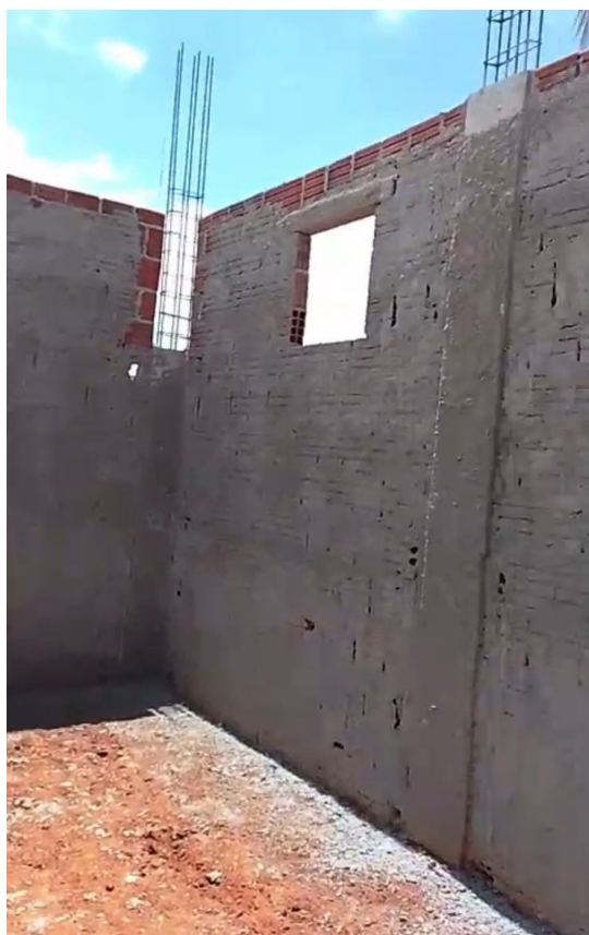
Figura 5. Aplicação de chapisco em alvenaria.
