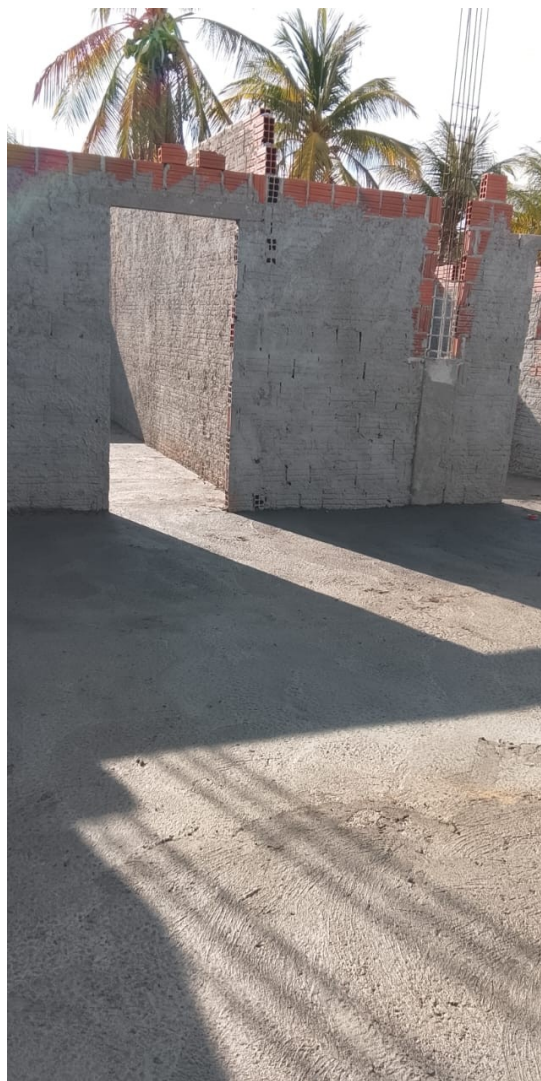
Figura 8. Aplicação de lastro de concreto magro em áreas de piso.
