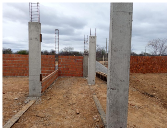
Figura 8. Concretagem dos pilares.
