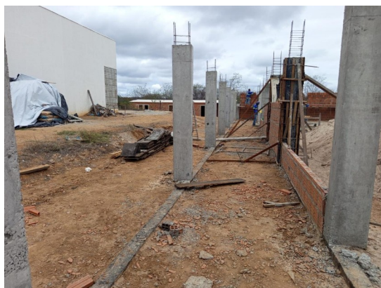
Figura 7. Concretagem dos pilares.
