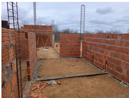
Figura 4. Execução de alvenaria de blocos cerâmicos.
