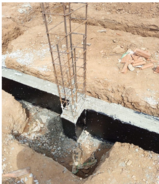
Figura 2. Impermeabilização de vigas baldrames.
