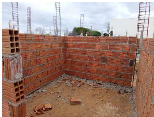
Figura 3. Execução de alvenaria de blocos cerâmicos.
