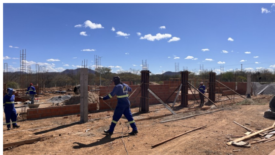
Figura 5. Armação e montagem de forma para concretagem de pilares.
