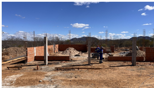
Figura 6. Armação e concretagem de pilares.
