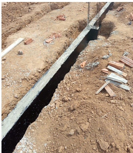
Figura 1. Impermeabilização de vigas baldrames.
