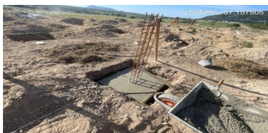
Figura 9. Concretagem de sapatas.
