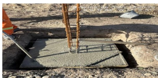
Figura 12. Concretagem de sapatas.
