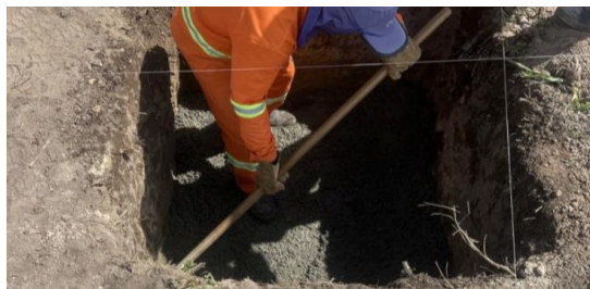
Figura 1. Escavação de valas para sapatas.
