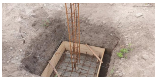
Figura 8. Montagem de armação de sapatas.
