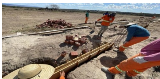
Figura 16. Montagem de formas em madeira para vigas baldrame.
