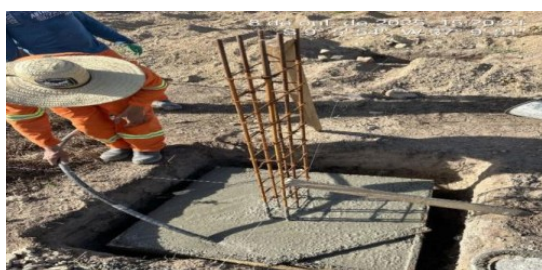
Figura 11. Concretagem de sapatas.
