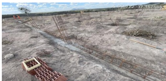
Figura 13. Execução de lastro e armação de vigas baldrames.
