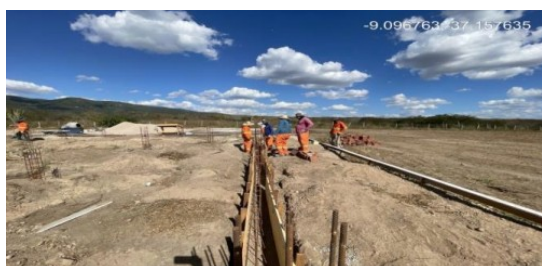
Figura 17. Montagem de formas em madeira para vigas baldrame.
