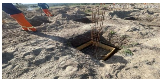
Figura 10. Concretagem de sapatas.
