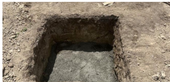
Figura 2. Escavação de valas para sapatas.
