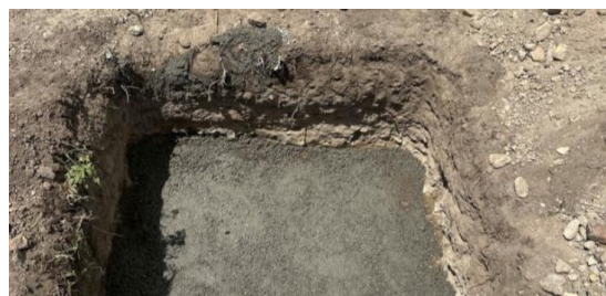
Figura 4. Execução de lastro de concreto em valas de sapatas.
