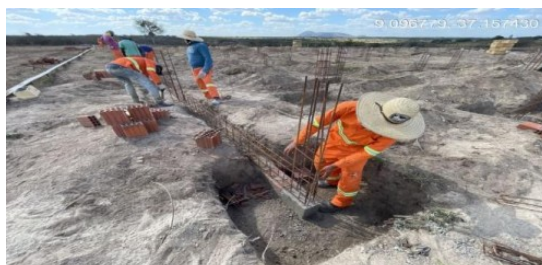
Figura 14. Execução de lastro e armação de vigas baldrame.
