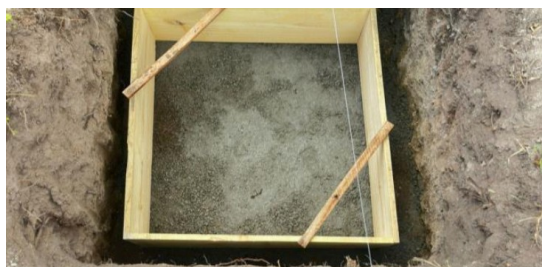
Figura 5. Montagem de forma de madeira para sapatas.
