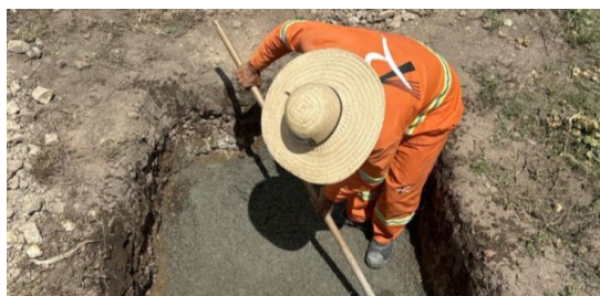
Figura 3. Execução de lastro de concreto em valas de sapatas.
