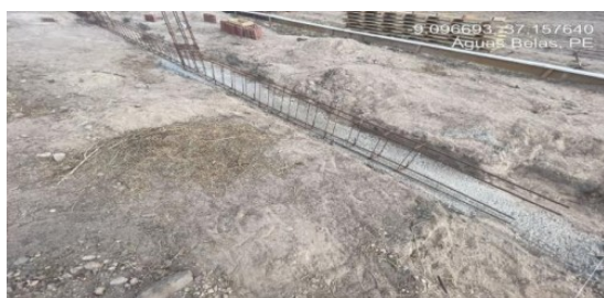
Figura 15. Execução de lastro e armação de vigas baldrame.
