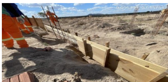
Figura 18. Montagem de formas em madeira para vigas baldrame.
