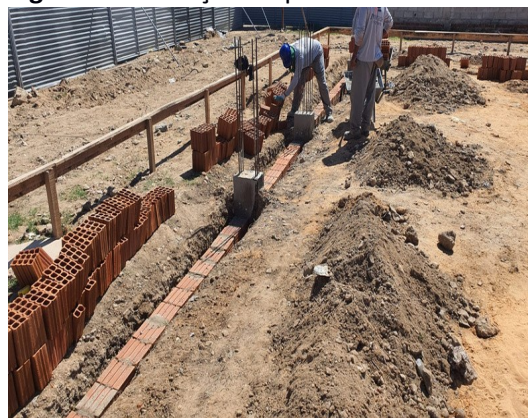
Figura 18. Execução de alvenaria de embasamento.
