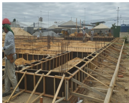
Figura 6. Montagem e escoramento de forma de madeira para vigas baldrame.
