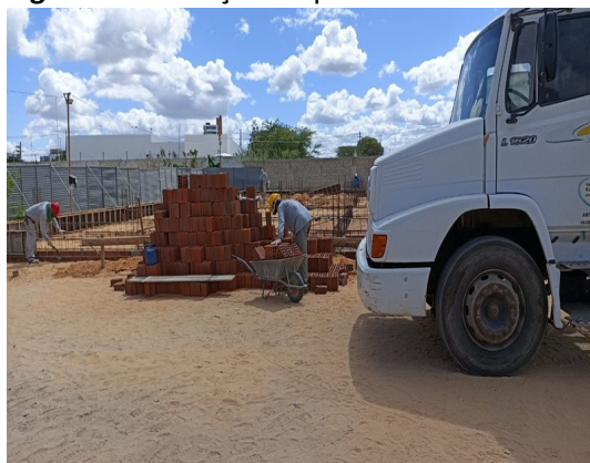
Figura 17. Execução de alvenaria de embasamento.
