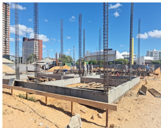
Figura 16. Armação de pilares.
