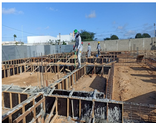
Figura 9. Concretagem de vigas baldrames.
