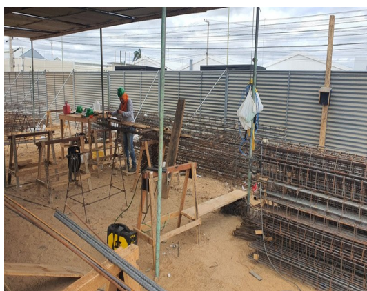
Figura 13. Fabricação de armação de vigas do 1º pavimento.
