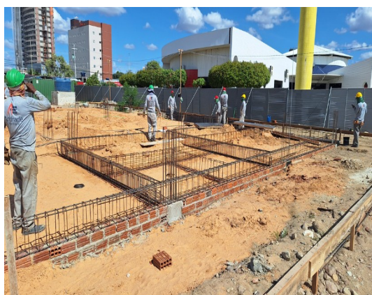
Figura 7. Armação de vigas baldrame
