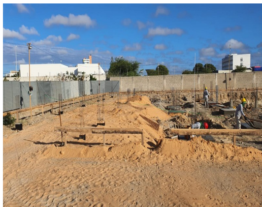
Figura 1. Reaterro de valas escavadas e aterro de caixão.
