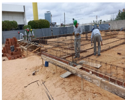
Figura 8. Armação de vigas baldrame
