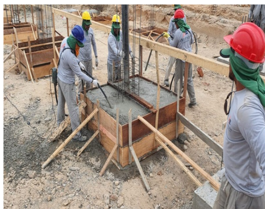
Figura 5. Concretagem de sapatas.
