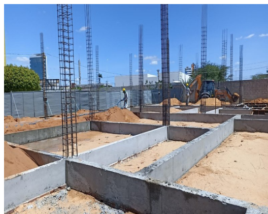
Figura 10. Concretagem de vigas baldrames e armação de pilares.
