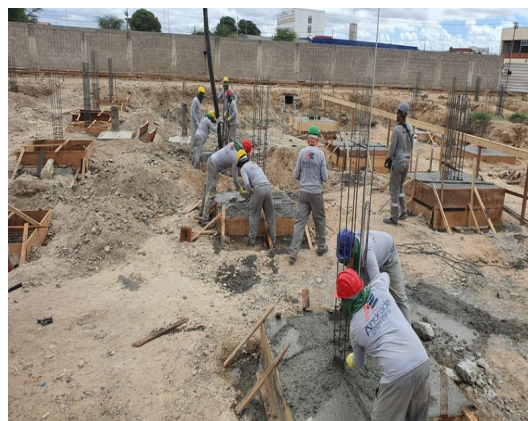
Figura 4. Concretagem de sapatas.
