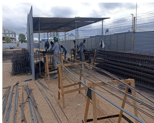
Figura 12. Fabricação de armação de pilares e vigas do 1º pavimento.
