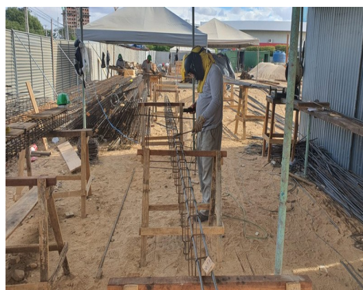
Figura 14. Fabricação de armação de vigas do 1º pavimento.
