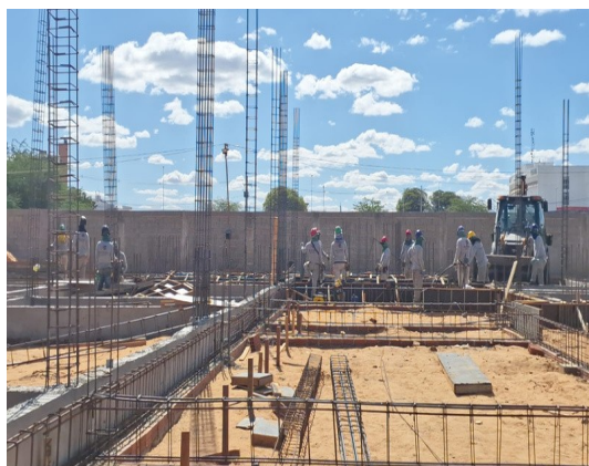
Figura 15. Armação de pilares.
