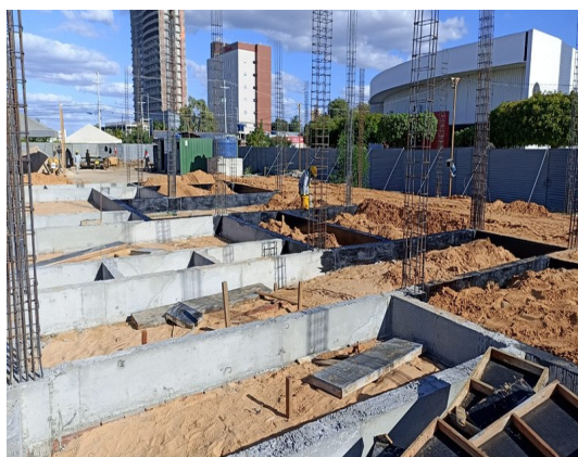
Figura 11. Impermeabilização de vigas baldrames.
