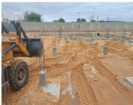
Figura 3. Regularização e compactação do aterro.
