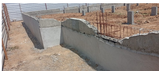
Figura 3. Alvenaria de embasamento executada.
