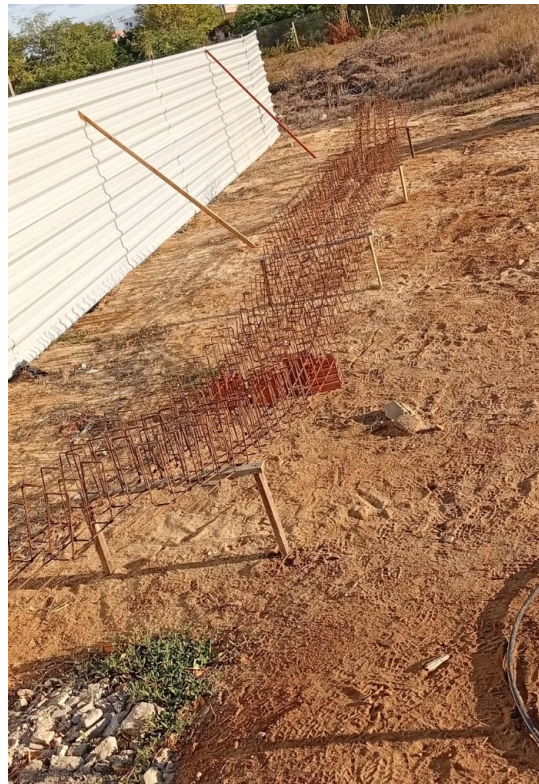
Figura 6. Armação de vigas baldrames.
