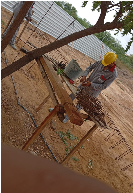
Figura 5. Armação de vigas baldrames.
