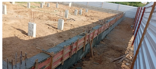
Figura 10. Concretagem de vigas baldrames.
