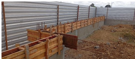
Figura 9. Montagem de formas de vigas baldrames.
