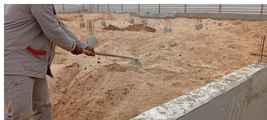
Figura 2. Aterro de caixão.
