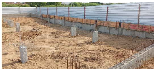
Figura 7. Armação e montagem de formas de vigas baldrames.
