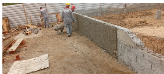
Figura 4. Aplicação de revestimentos argamassados em alvenaria de embasamento.
