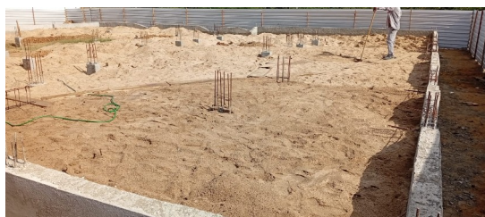
Figura 1. Aterro de caixão.
