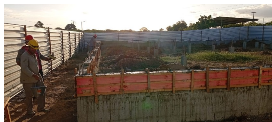
Figura 8. Montagem de formas de vigas baldrames.
