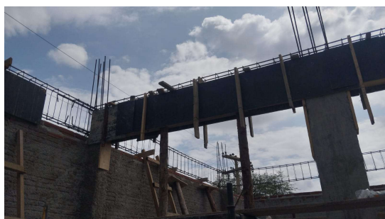
Figura 5. Forma de vigas.
