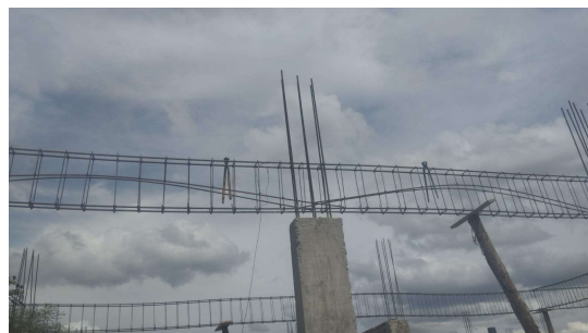
Figura 2. Montagem de armação de vigas.
