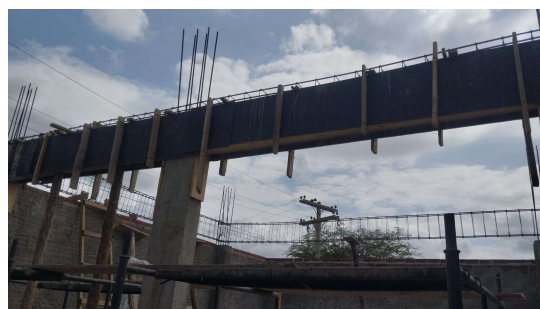
Figura 6. Forma de vigas.
