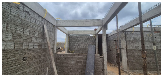
Figura 5. Concretagem de vigas, f_{ck}=25\text{MPa}
