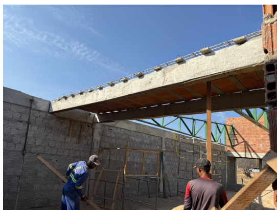
Figura 3. Execução de laje pré-moldada unidirecional, biapoiada.
