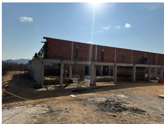
Figura 7. Execução de alvenaria de vedação de blocos cerâmicos.
