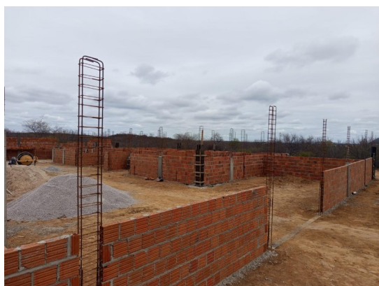
Figura 1. Armação de pilares.
