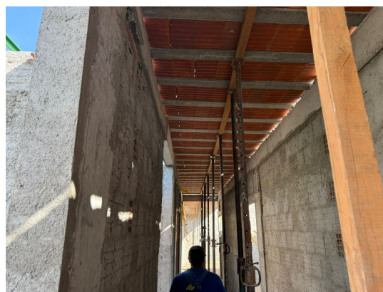
Figura 4. Execução de laje pré-moldada unidirecional, biapoiada.
