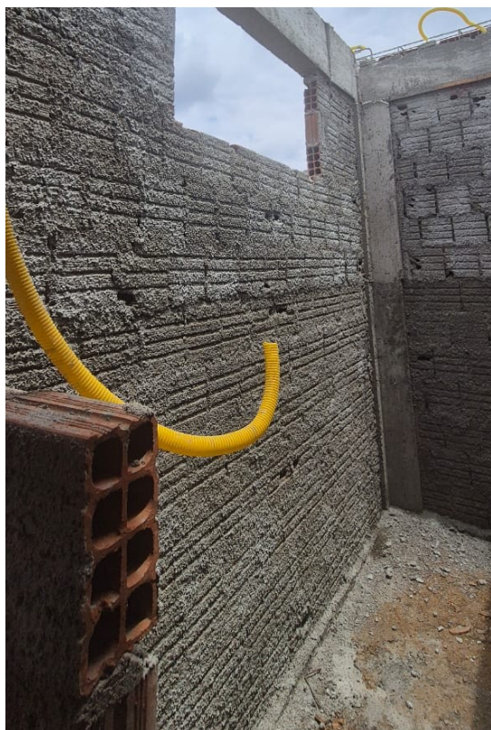
Figura 13. Aplicação de chapisco em alvenaria.
