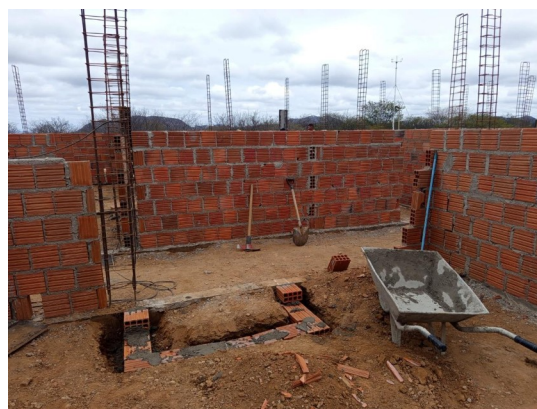
Figura 2. Armação de pilares.
