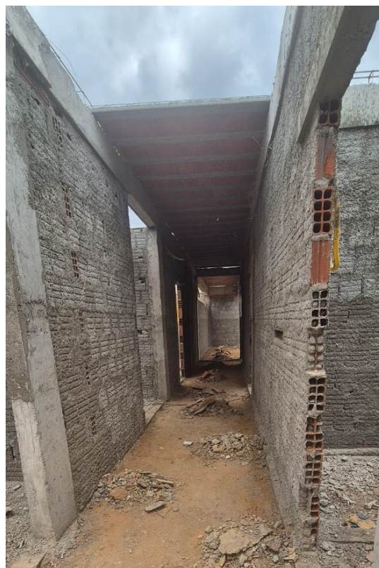
Figura 14. Aplicação de chapisco em alvenaria.
