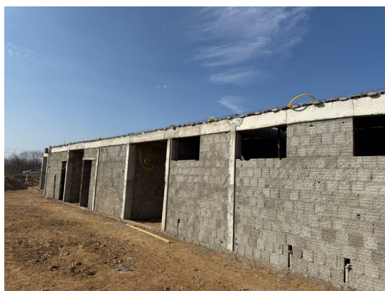
Figura 11. Aplicação de chapisco em alvenaria.
