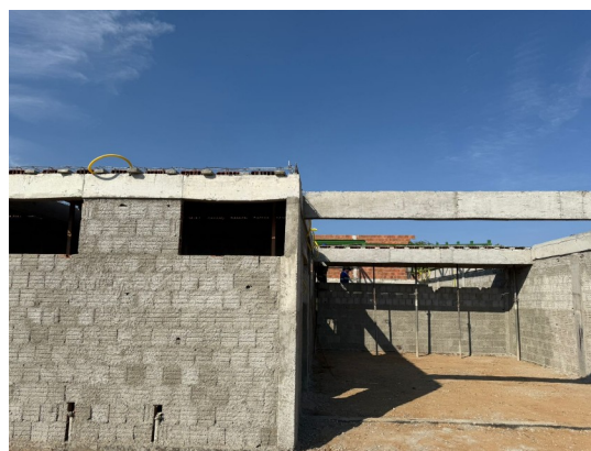
Figura 12. Aplicação de chapisco em alvenaria.
