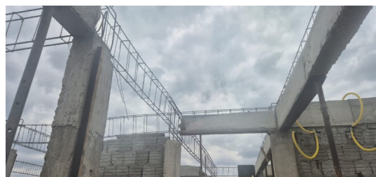
Figura 6. Concretagem de vigas, f_{ck}=25\text{MPa}
