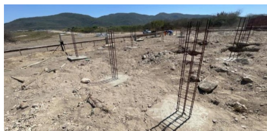
Figura 4. Montagem de armação de pilares.
