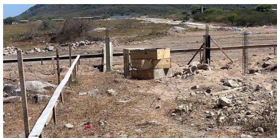
Figura 5. Montagem de forma de madeira para sapatas.
