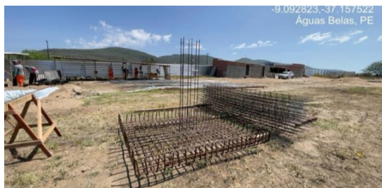
Figura 1. Montagem de armação de sapatas.
