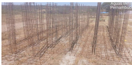
Figura 3. Montagem de armação de pilares.
