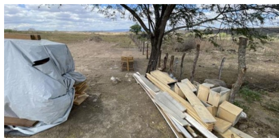
Figura 6. Montagem de forma de madeira para sapatas e baldrame.
