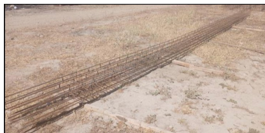
Figura 2. Montagem de armação de vigas baldrame.
