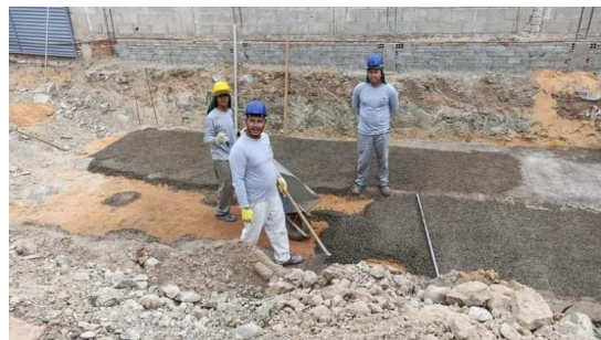
Figura 16. Execução de lastro de concreto do reservatório inferior.
