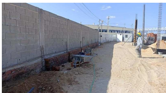
Figura 7. Assentamento de alvenaria de embasamento do muro.
