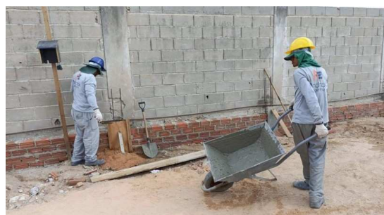
Figura 8. Assentamento de alvenaria de embasamento do muro e escavação da fundação.
