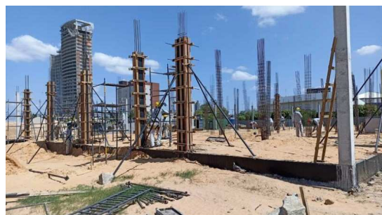
Figura 12. Concretagem de pilares.
