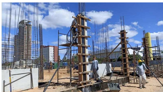
Figura 11. Concretagem de pilares.
