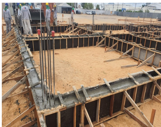
Figura 1. Concretagem de vigas baldrame.
