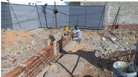
Figura 13. Concretagem de arranque de pilares do muro.
