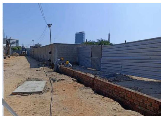
Figura 10. Assentamento de alvenaria de vedação do muro.
