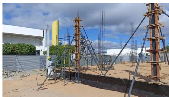
Figura 4. Montagem de forma de pilares.
