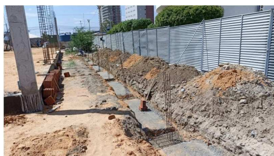
Figura 9. Execução de lastro de concreto e armação de pilares do muro.
