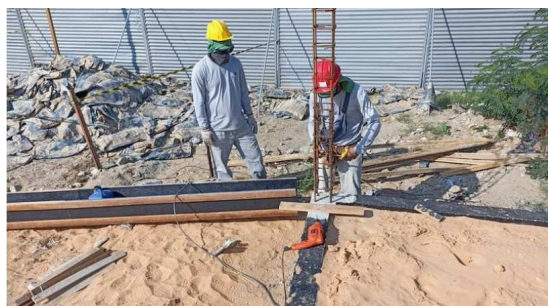
Figura 5. Montagem de forma de pilares.
