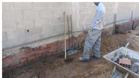
Figura 6. Execução de lastro de concreto para embasamento do muro de alvenaria.
