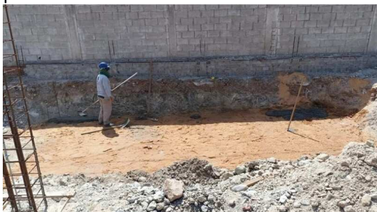
Figura 15. Regularização da base do reservatório inferior.
