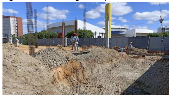
Figura 14. Escavação do reservatório inferior.
