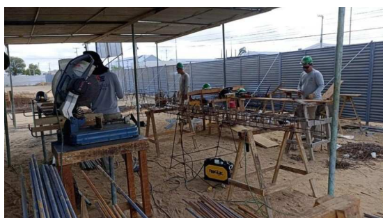
Figura 3. Fabricação de armação de pilares.
