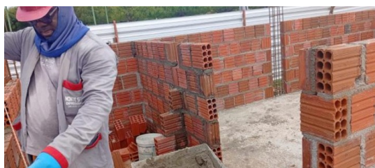
Figura 2. Execução de alvenaria de blocos cerâmicos.
