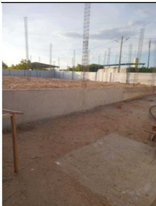
Figura 3. Armação de pilares.
