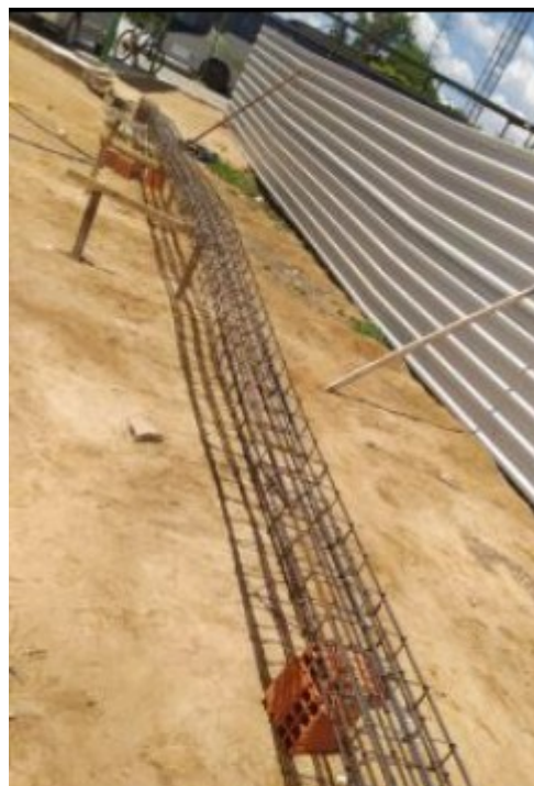
Figura 4. Armação de pilares.
