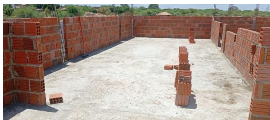
Figura 1. Execução de alvenaria de blocos cerâmicos.
