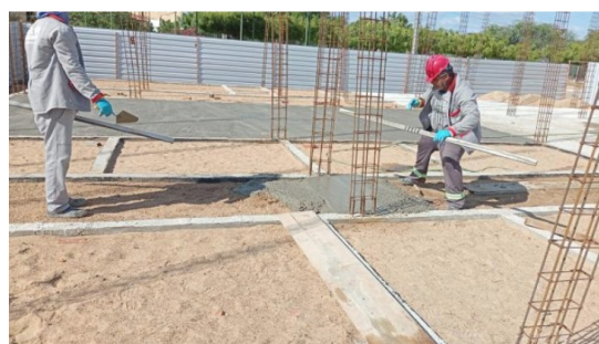
Figura 6. Execução de lastro de concreto magro.
