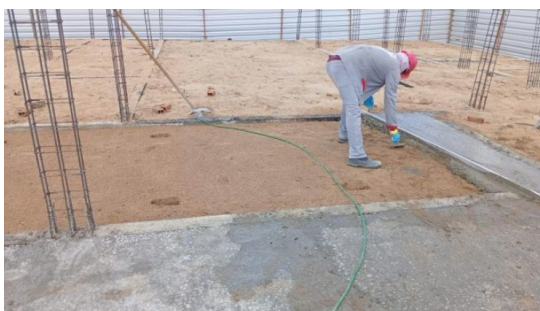
Figura 5. Execução de lastro de concreto magro.
