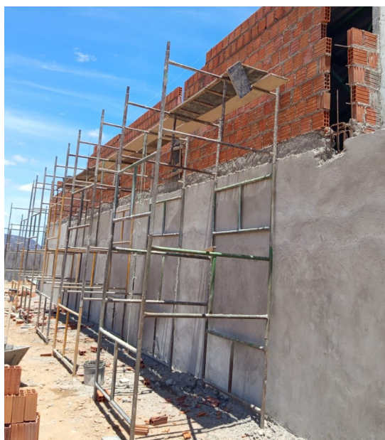
Figura 7. Aplicação de massa única em alvenaria.
