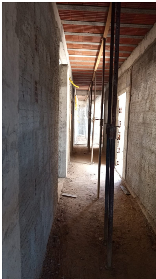
Figura 2. Execução de laje pré-moldada unidirecional, biapoiada.
