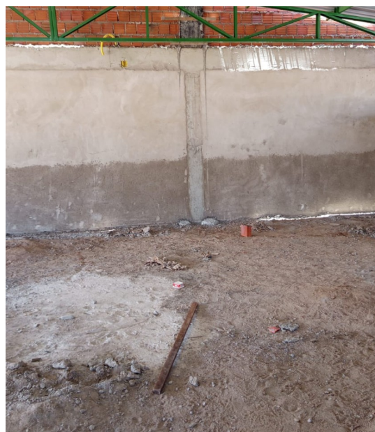
Figura 8. Aplicação de emboço em alvenaria.
