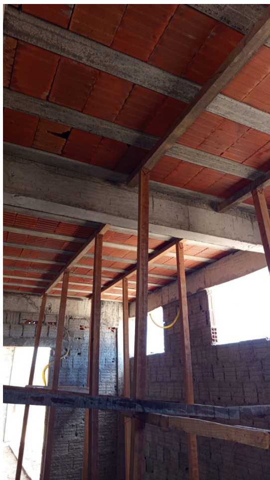
Figura 1. Execução de laje pré-moldada unidirecional, biapoiada.
