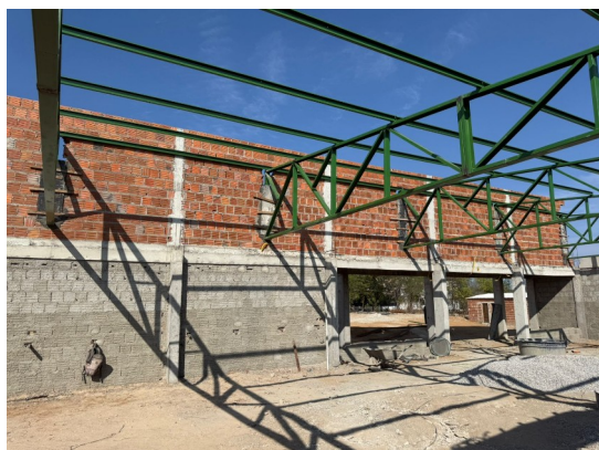
Figura 3. Execução de estrutura metálica (tesouras e trama) para cobertura.
