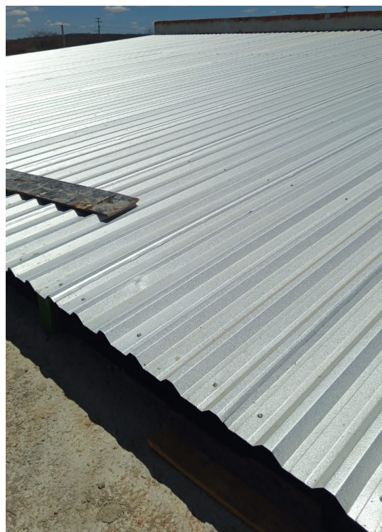
Figura 6. Telhamento com telha de aço/alumínio e=0,5\text{mm} .
