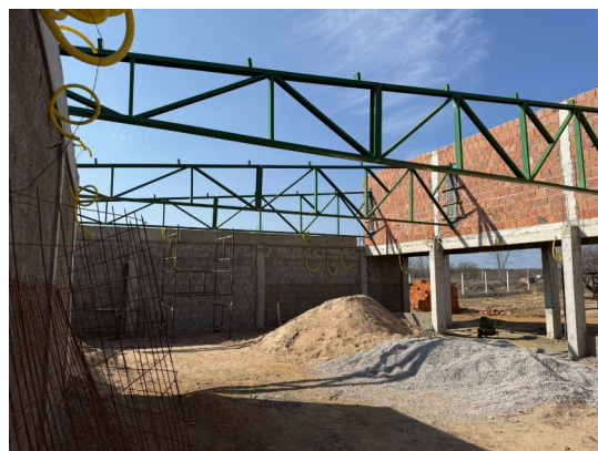
Figura 4. Execução de estrutura metálica (tesouras e trama) para cobertura.
