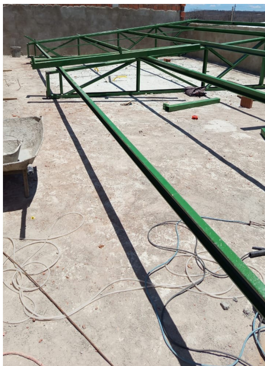
Figura 5. Execução de estrutura metálica (tesouras e trama) para cobertura.
