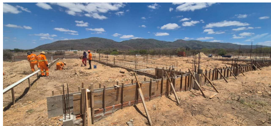
Figura 2. Montagem de forma e armação de vigas baldrames.
