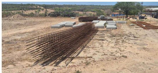
Figura 6. Armação de vigas baldrames.
