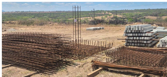
Figura 3. Montagem de armação de sapatas e pilares.
