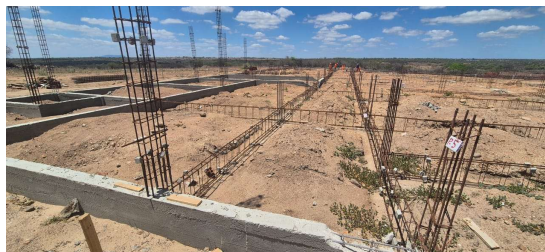
Figura 4. Armação de pilares.
