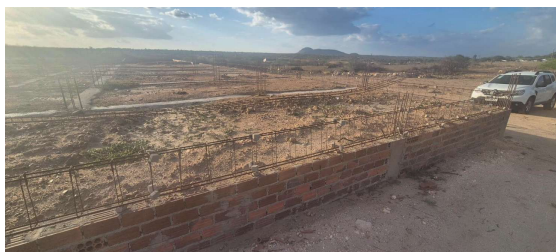
Figura 1. Alvenaria de embasamento e armação de vigas baldrames.
