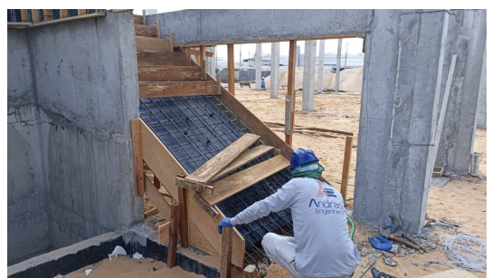
Figura 14. Montagem de formas de escada.
