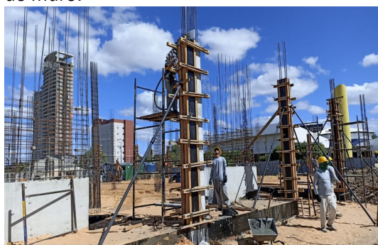
Figura 5. Concretagem de pilares.
