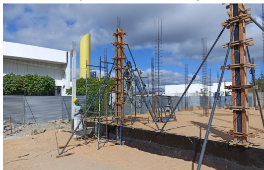
Figura 1. Montagem de forma de pilares.
