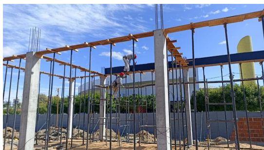
Figura 9. Montagem de forma de vigas.
