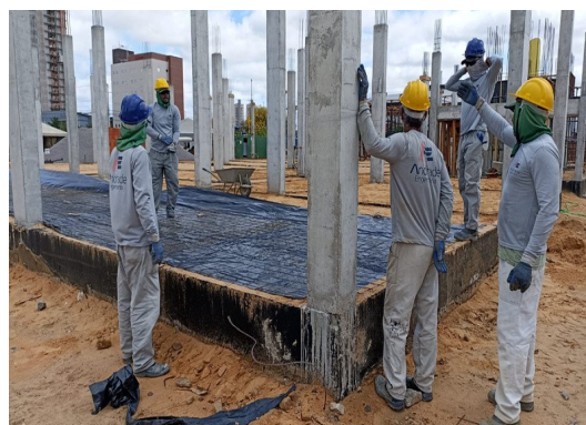
Figura 18. Montagem de armação de laje de piso.
