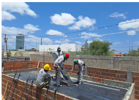
Figura 15. Montagem de forma de laje do reservatório inferior.
