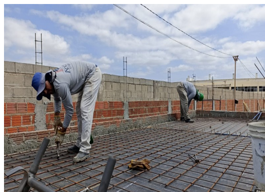
Figura 16. Armação de laje do reservatório inferior.
