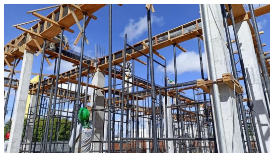
Figura 10. Montagem de forma de vigas.
