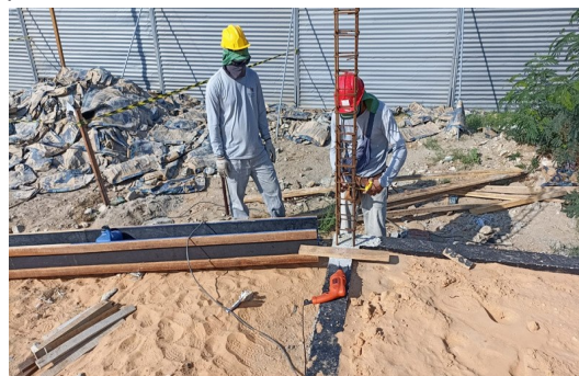
Figura 2. Montagem de forma de pilares.
