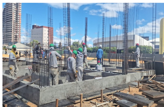
Figura 4. Montagem de armação de pilares.
