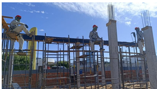
Figura 7. Montagem de forma de vigas e concretagem de pilares.
