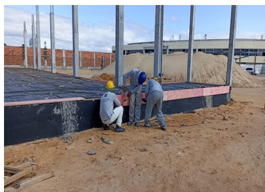
Figura 20. Montagem de forma de laje de piso.
