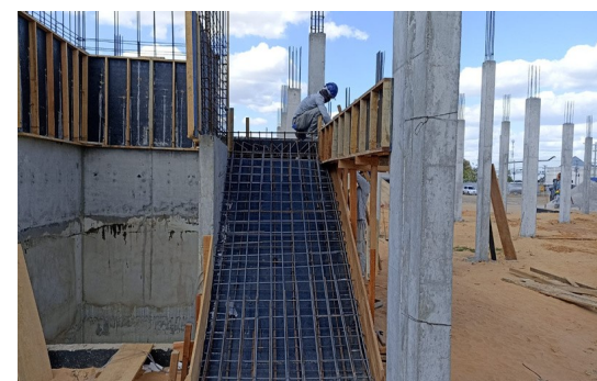
Figura 12. Armação de laje da escada.
