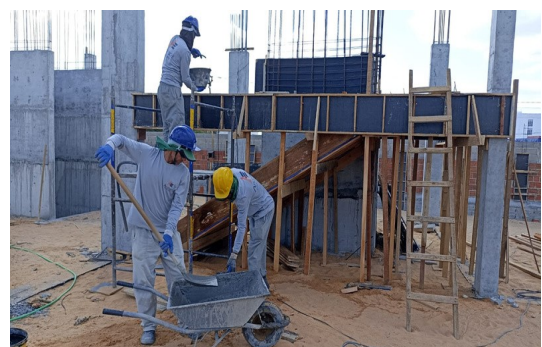
Figura 11. Concretagem das vigas da escada.
