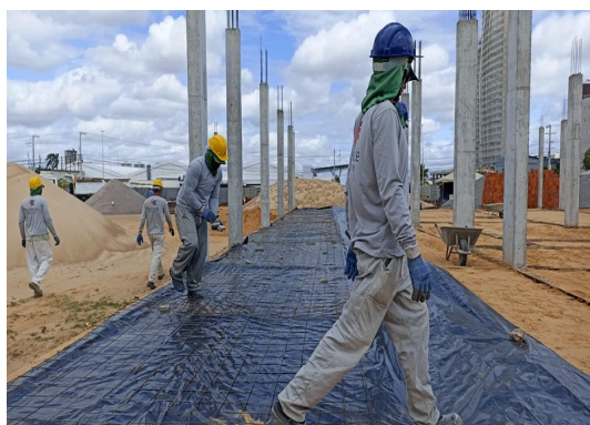
Figura 17. Impermeabilização de laje de piso.
