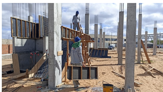
Figura 13. Montagem de formas de escada.
