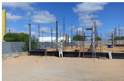
Figura 6. Concretagem de pilares.
