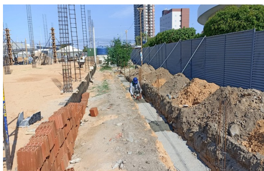
Figura 3. Montagem de armação de pilares do muro.
