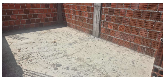
Figura 6. Execução de lastro de concreto magro.
