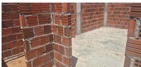
Figura 5. Execução de lastro de concreto magro.
