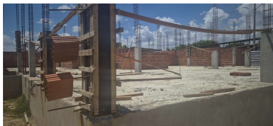
Figura 3. Forma, armação e concreto de pilares.
