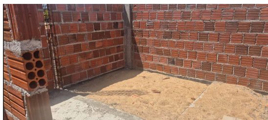
Figura 1. Execução de alvenaria de blocos
