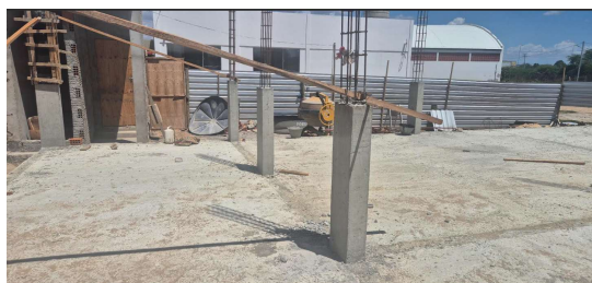
Figura 2. Execução de pilares.
