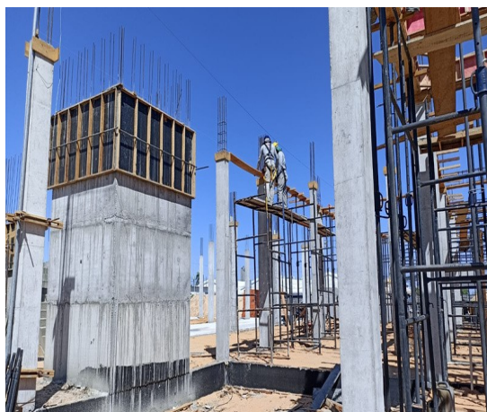
Figura 1. Montagem de forma de pilares do poço do elevador.
