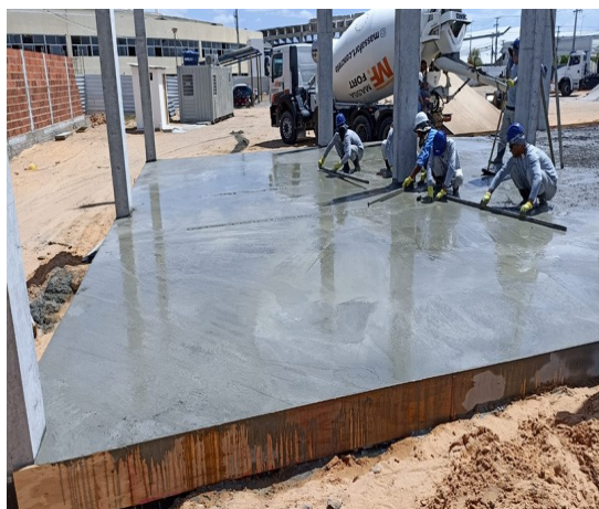
Figura 5. Nivelamento de piso concretado.
