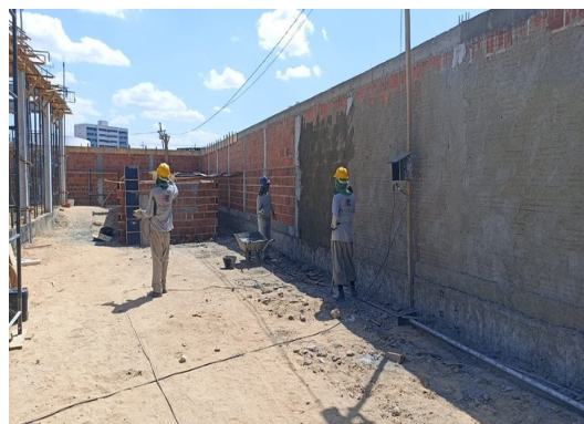
Figura 12. Aplicação de chapisco no muro.
