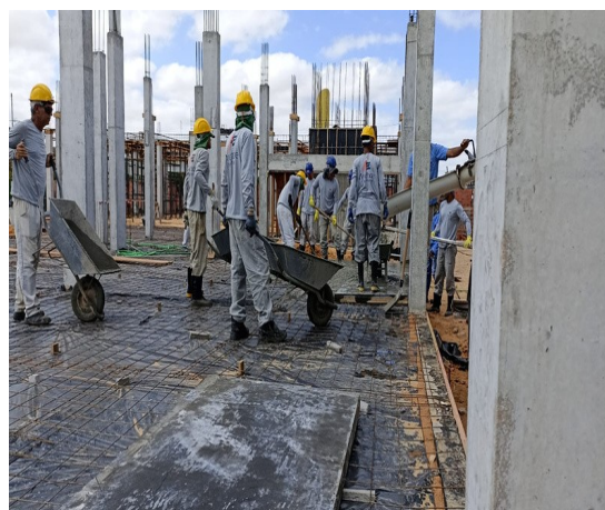
Figura 4. Concretagem de laje de piso.
