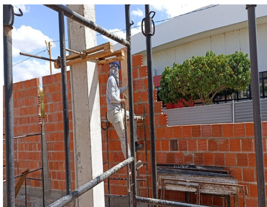
Figura 9. Execução de alvenaria de vedação do muro.
