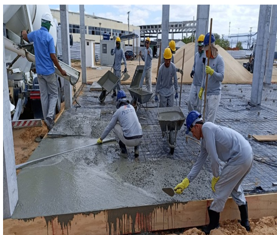
Figura 3. Concretagem de laje de piso.
