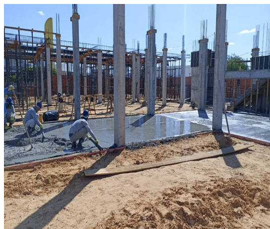
Figura 6. Nivelamento de piso concretado.
