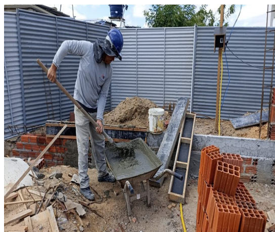
Figura 8. Concretagem de viga de embasamento do muro.
