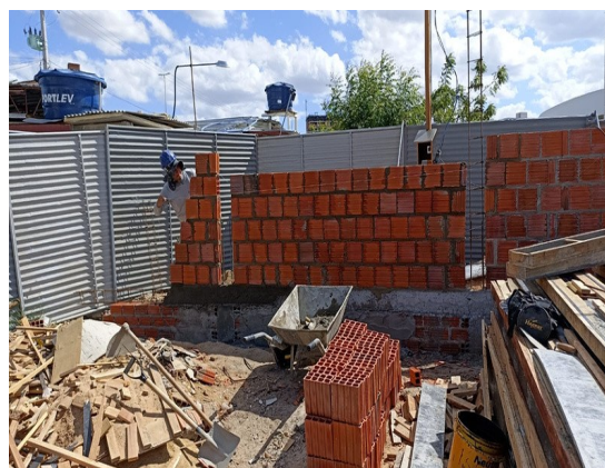
Figura 10. Execução de alvenaria de vedação do muro.
