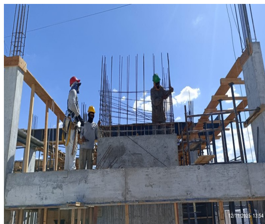
Figura 2. Montagem de armação do pilar caixão do elevador.
