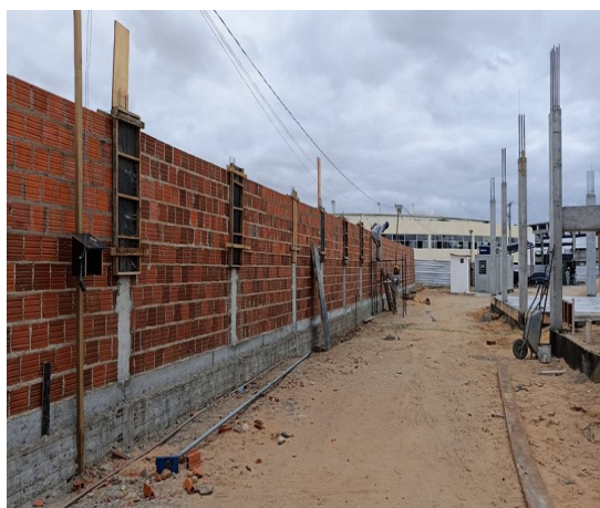
Figura 7. Desmontagem de forma de pilares do muro.
