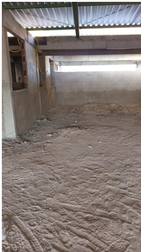
Figura 4. Execução de aterro de caixão nas áreas de implantação de piso.
