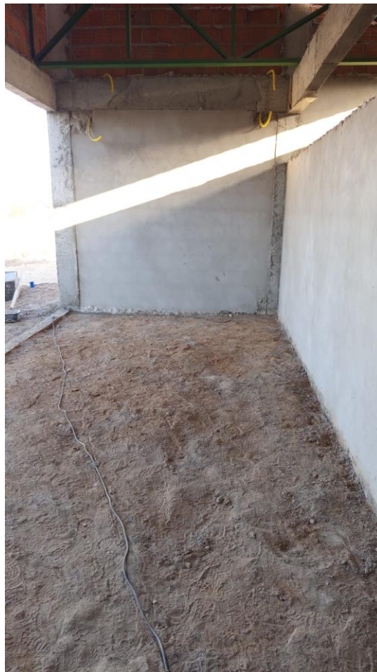
Figura 6. Execução de aterro de caixão nas áreas de implantação de piso.
