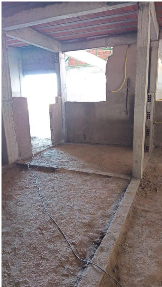
Figura 5. Execução de aterro de caixão nas áreas de implantação de piso.
