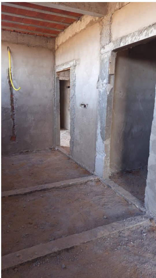
Figura 3. Instalação de vergas em vão de portas.
