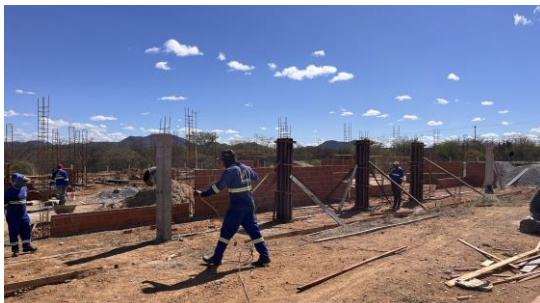
Figura 1. Montagem e desmontagem de forma de pilares.
