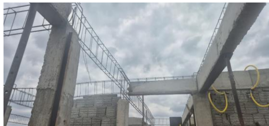
Figura 2. Armação de vigas.
