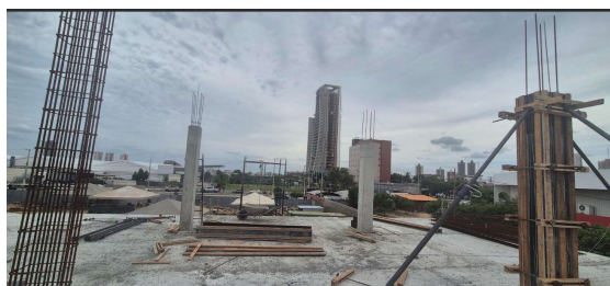
Figura 1. Armação de pilares.
