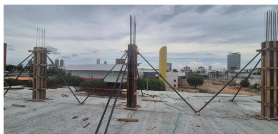
Figura 6. Forma de pilares.
