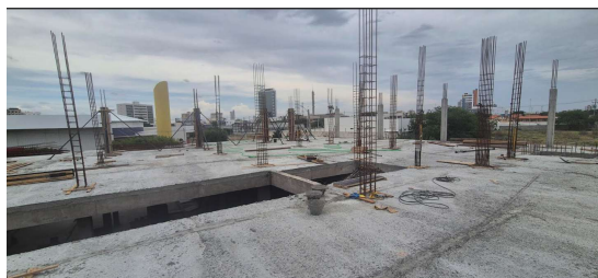
Figura 5. Concreto de laje e armação de pilares.
