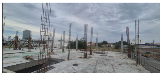
Figura 1. Armação de pilares.
