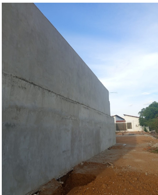
Figura 4. Aplicação de massaúnica e emboço em paredes externas.
