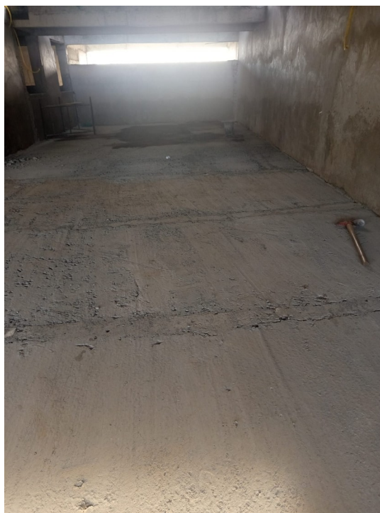
Figura 2. Aplicação de lastro de concreto em áreas de piso.
