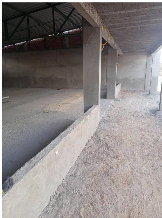
Figura 6. Aplicação de massaúnica e emboço em paredes internas e pilares.
