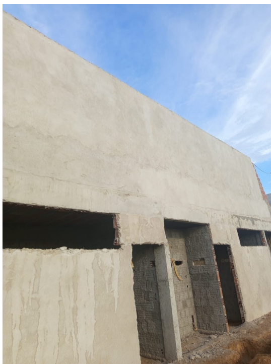
Figura 5. Aplicação de massaúnica e emboço em paredes externas.
