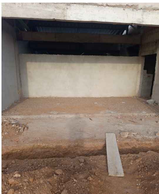
Figura 3. Execução de contrapiso.
