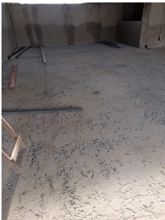
Figura 1. Aplicação de lastro de concreto em áreas de piso.
