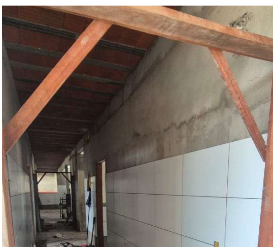
Figura 2. Execução de revestimento cerâmico 10x10 cm.
