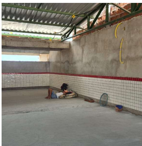
Figura 2. Execução de revestimento cerâmico 10x10 cm.
