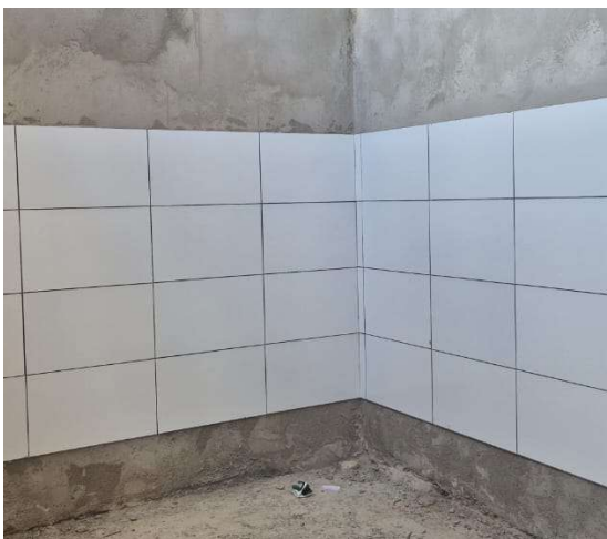
Figura 3. Execução de revestimento cerâmico 30x60 cm.
