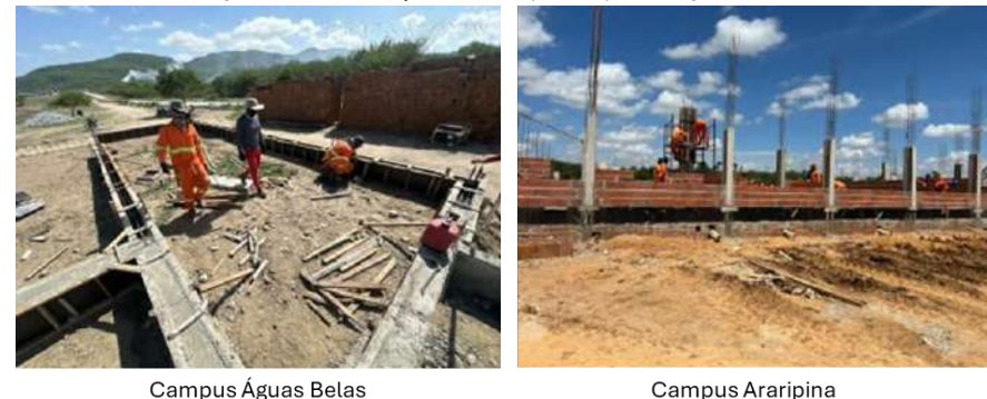
Figura 89 - Construção dos campi Araripina e Águas Belas.
