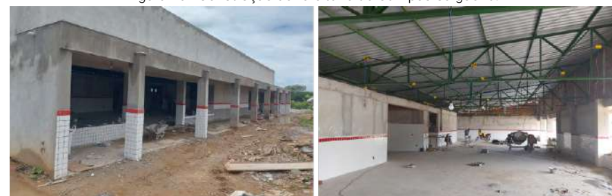
Figura 90 - Construção do refeitório do Campus Salgueiro.
