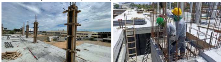
Figura 88 - Construção da sede própria da reitoria do IFSertãoPE.
