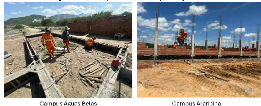
Figura 89 - Construção dos campi Araripina e Águas Belas.
