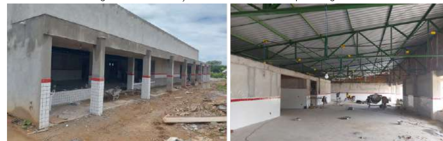
Figura 90 - Construção do refeitório do Campus Salgueiro.
