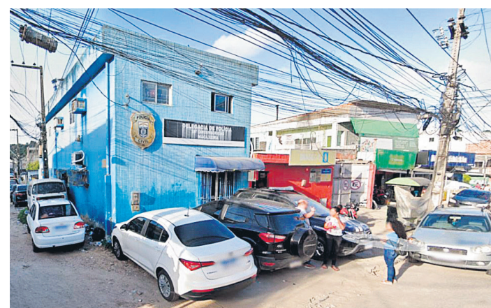
Atual prédio da delegacia passará por reformas
